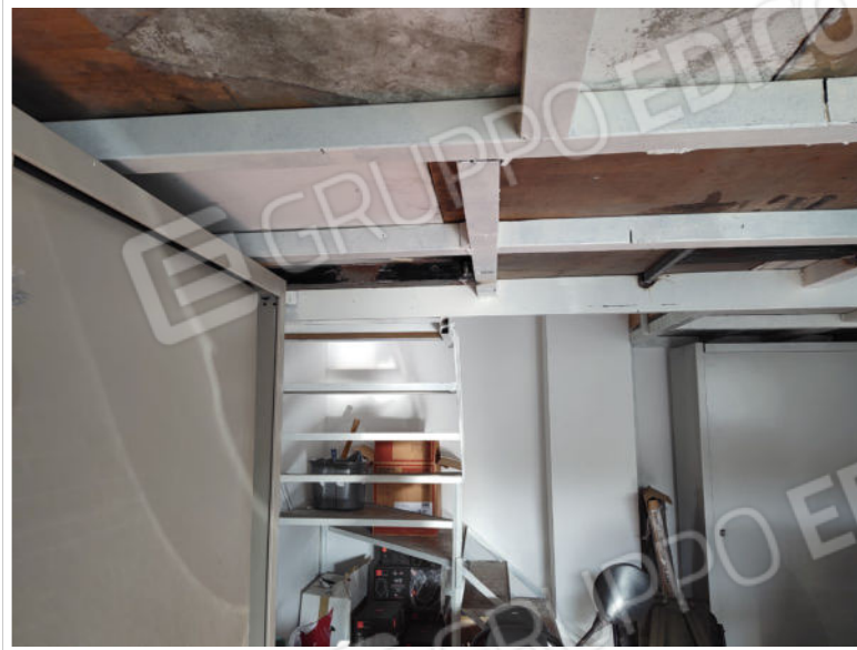
Foto n. 16 – Scala accesso soppalco garage
