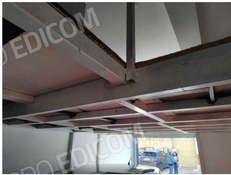
Foto n. 15 – Struttura soppalco garage
