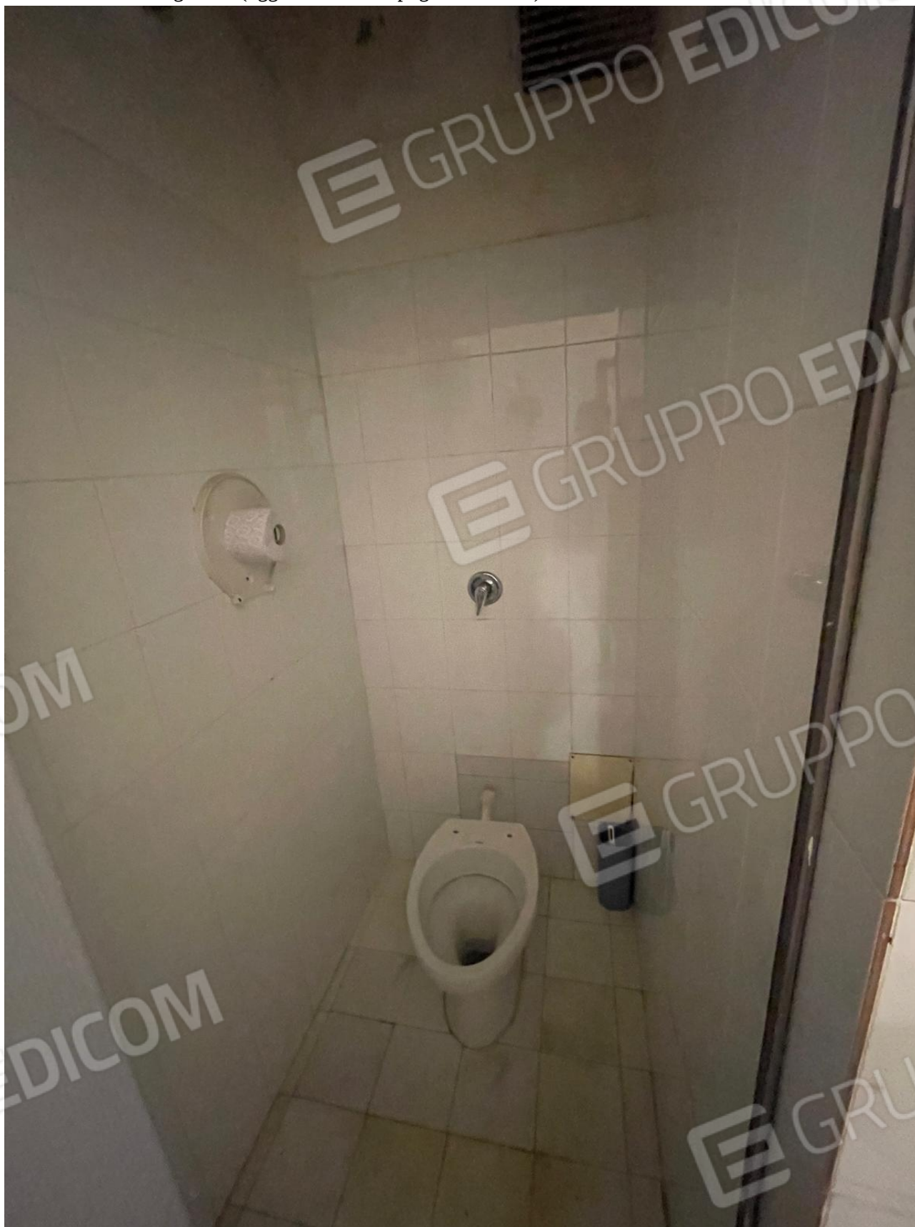
Foto 25 – Servizio igienico (oggi usato come spogliatoio - WC)
