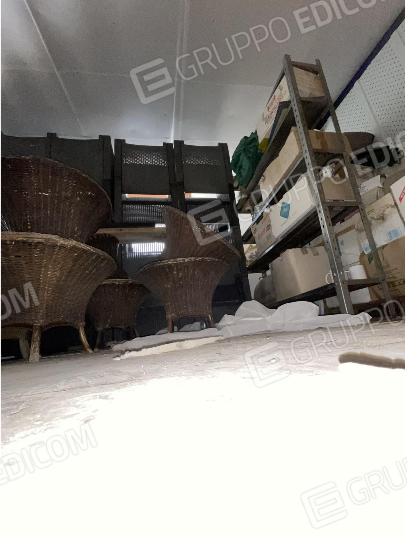
Foto 21 – Interno soppalco anteriore
