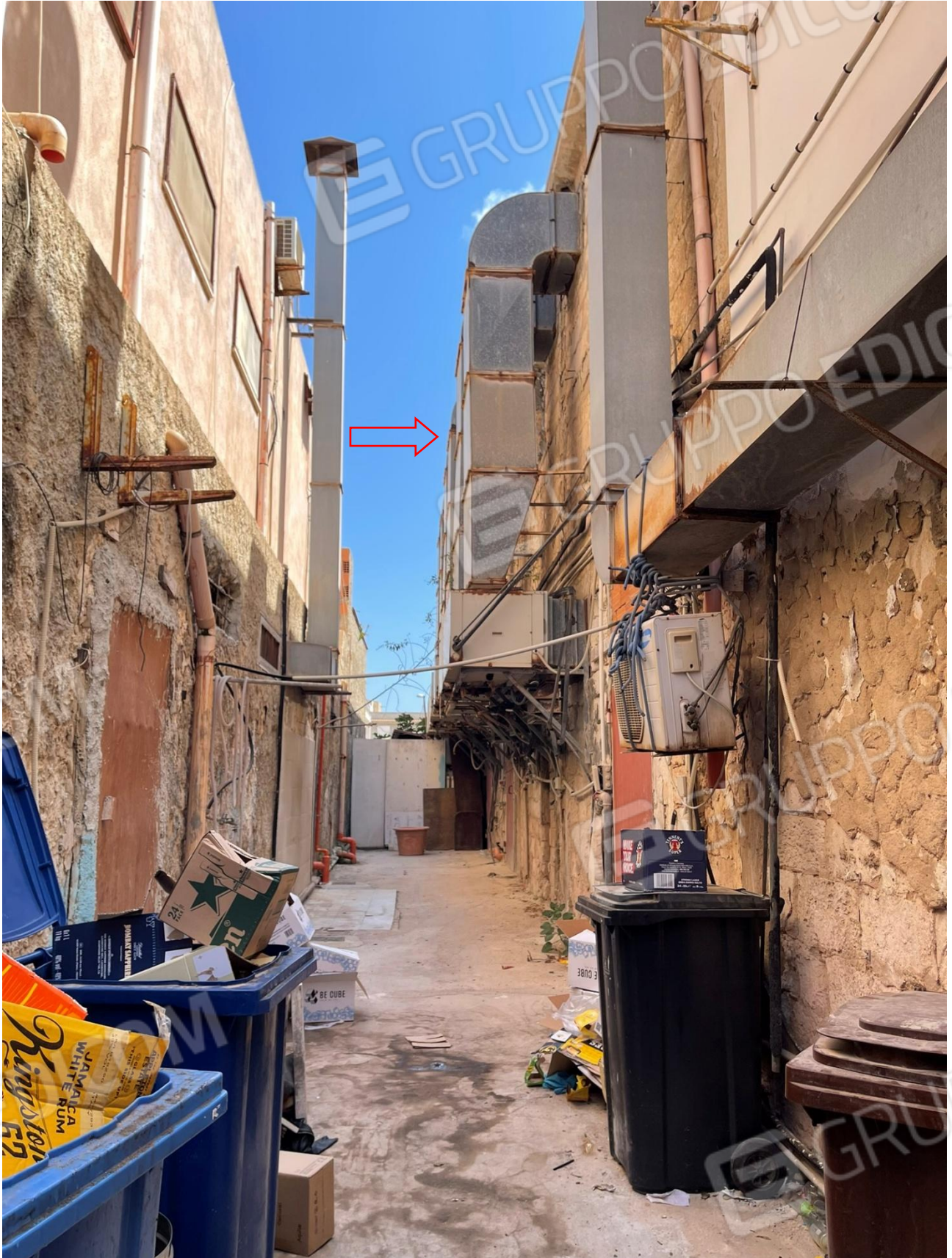
Foto 4 – Esterno retro dell'immobile
