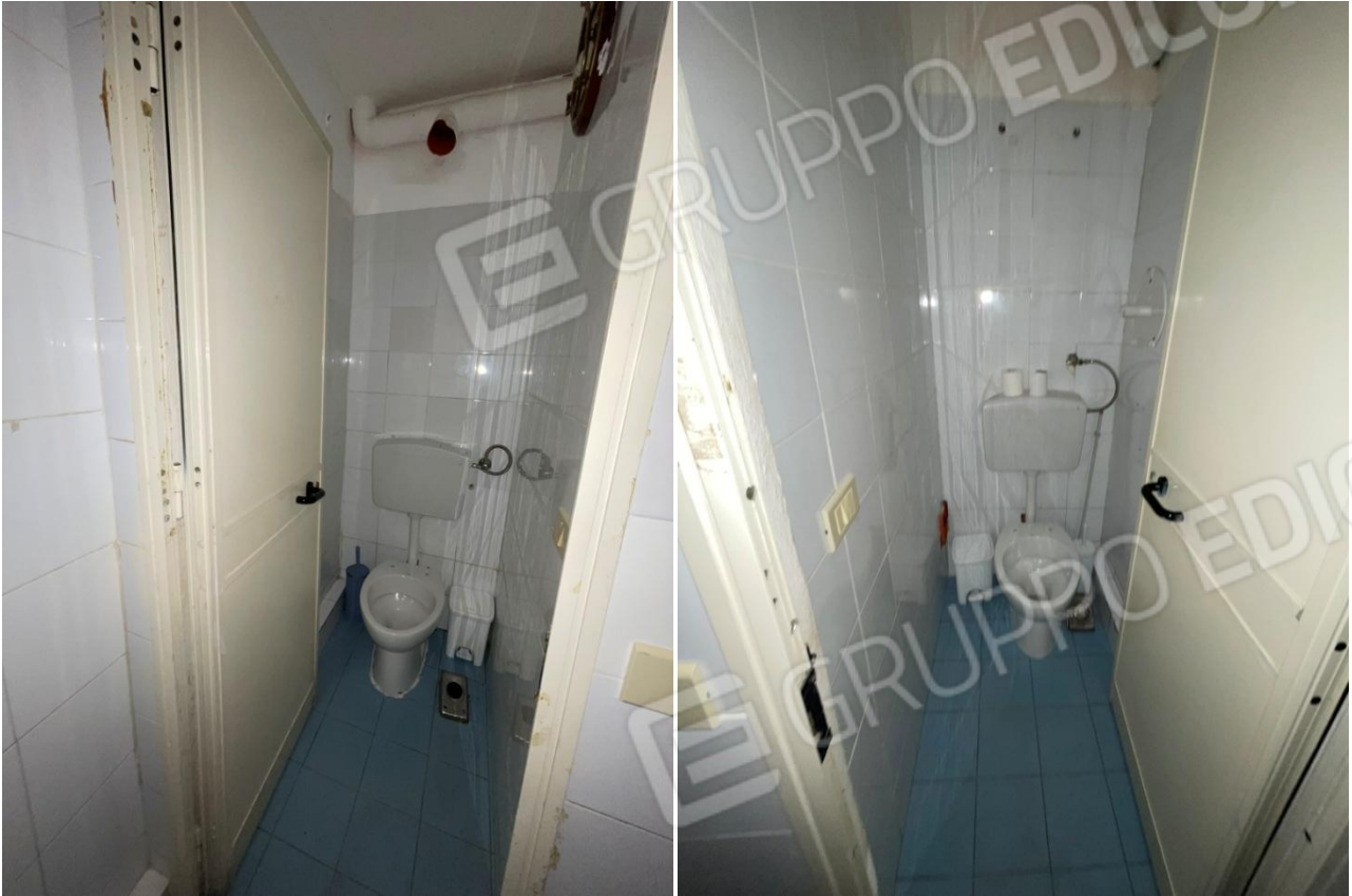
Foto 16 - 17 – Servizi igienici (WC)
