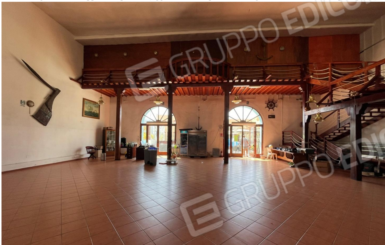
Foto 5 – Ingresso con soppalco superiore (oggi chiuso con pannelli di legno e utilizzato come ripostiglio)
