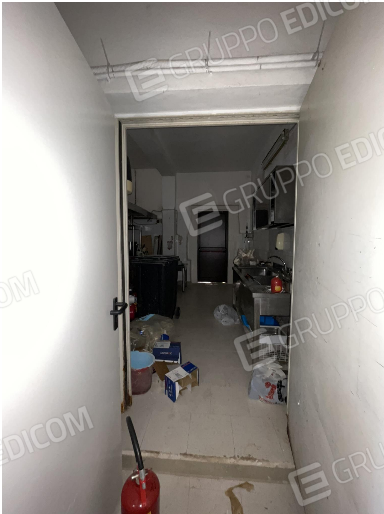
Foto 11 – Ingresso ripostiglio (ex cucina)
