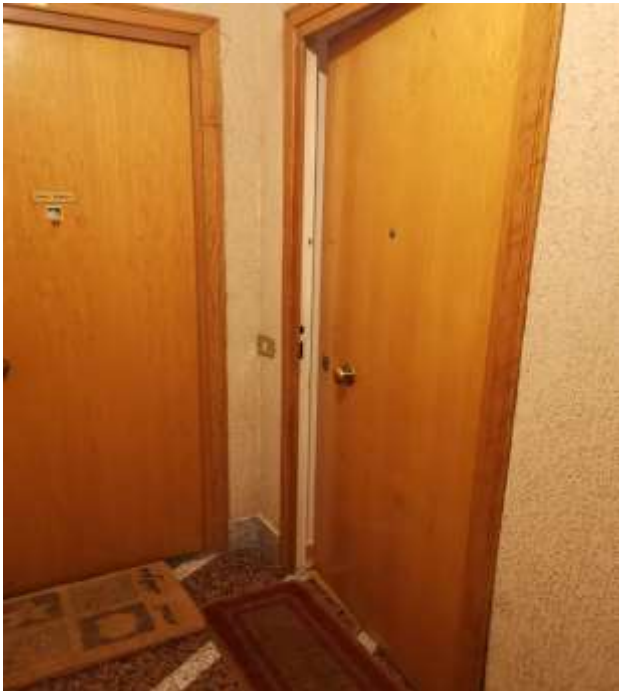
Foto n° 7 Porta ingresso appartamento
