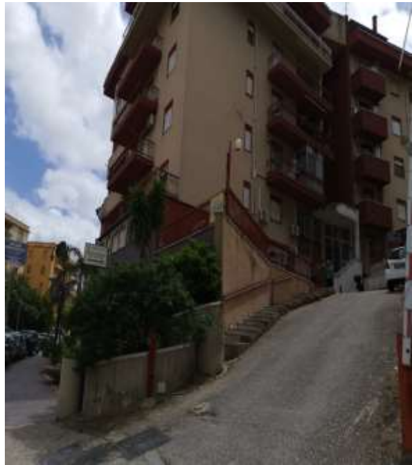
Foto n.2 Prospetto dalla traversa di via Imera
