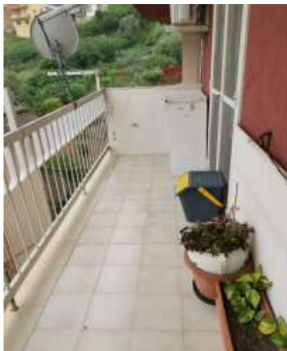
Foto n° 18 Balcone su area laterale
