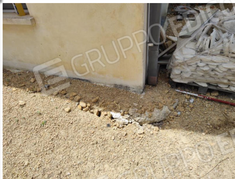
Foto n. 4 – Particolare fondazione fabbricato
