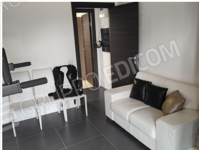
Foto n. 10 – Vano tecnico piano seminterrato
