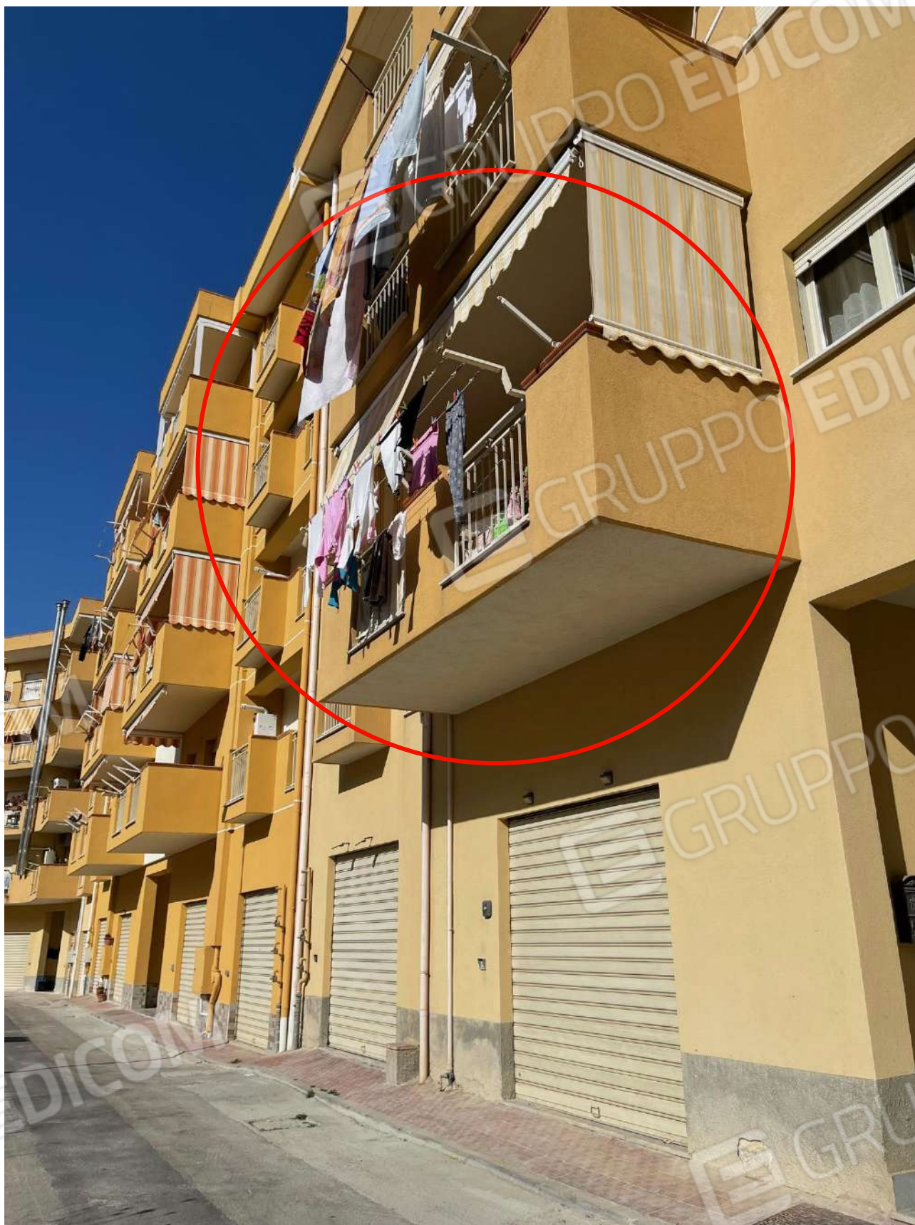
Foto 12 – Balcone su prospetto principale
