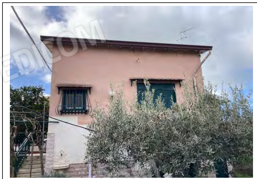
Foto 3 – Fabbricato Prospetto Nord/Est
