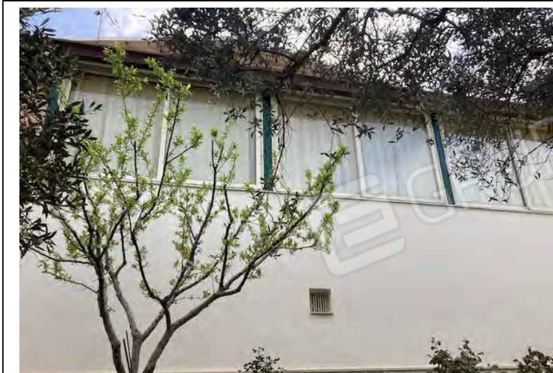
Foto 4 – Fabbricato Prospetto Nord/Ovest
