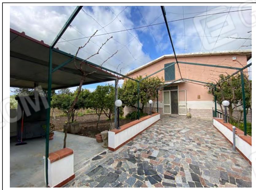
Foto 2 – Fabbricato Prospetto Sud/Est
