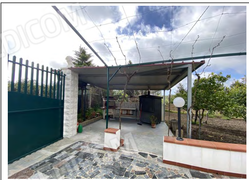
Foto 19 – Tettoia aperta sui lati
