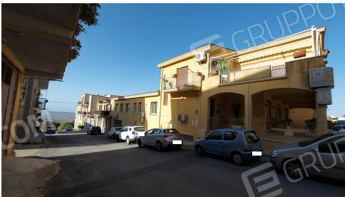
Foto 2 – prospetto laterale su via Colapuma
