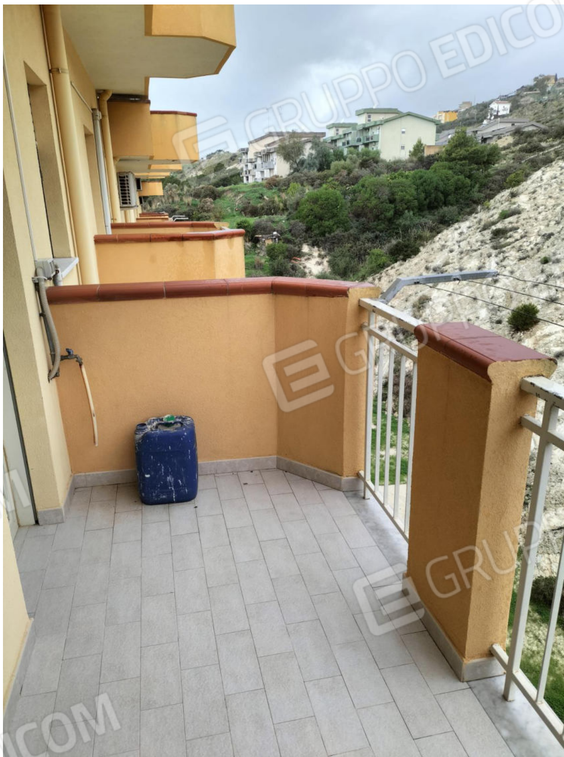
Balcone lato nord.
