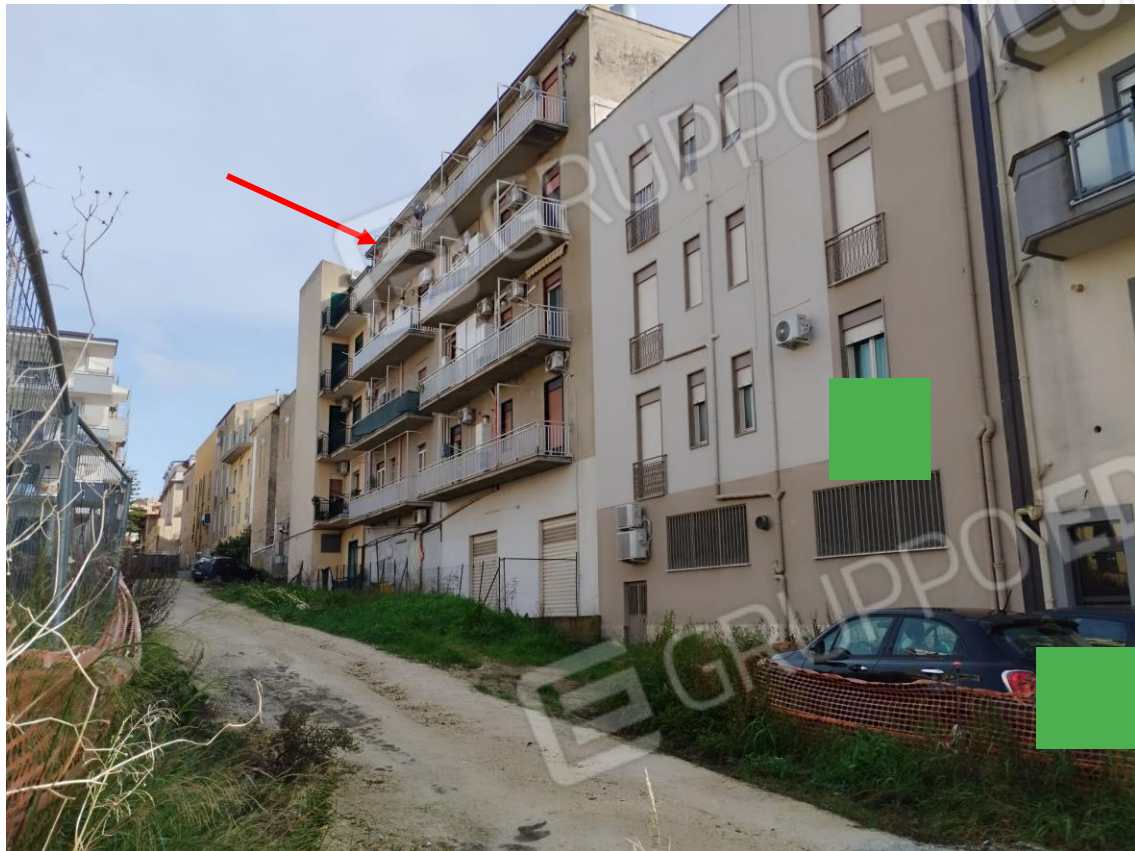
FOTO 3 – VEDUTA DELL'APPARTAMENTO POSTO AL QUARTO PIANO
