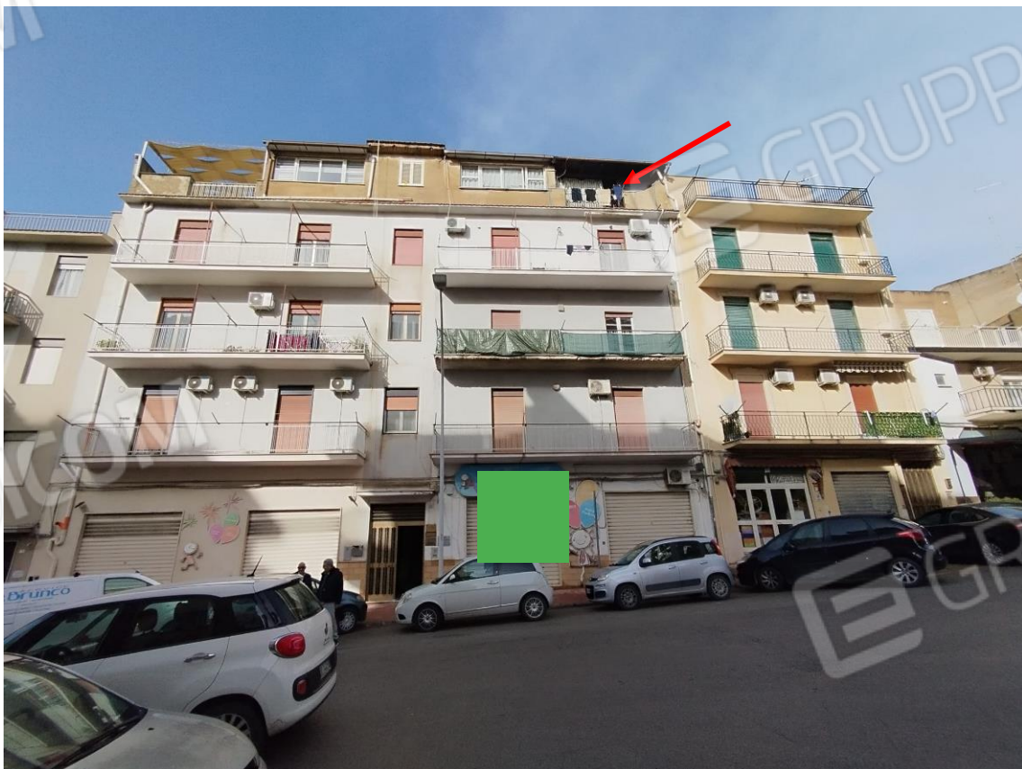
FOTO 4 – VEDUTA DELL'APPARTAMENTO DA VIA SENATORE SAMMARTINO
