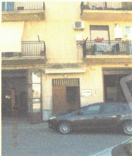
Foto 1 Prospetto ovest su Via Sergio Leone
