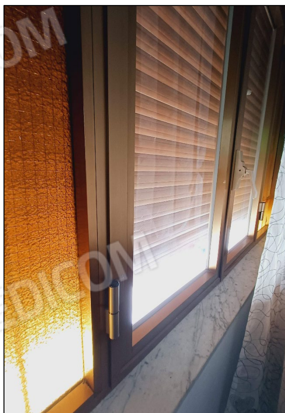
Figura 6 – Infissi in alluminio delle finestre
