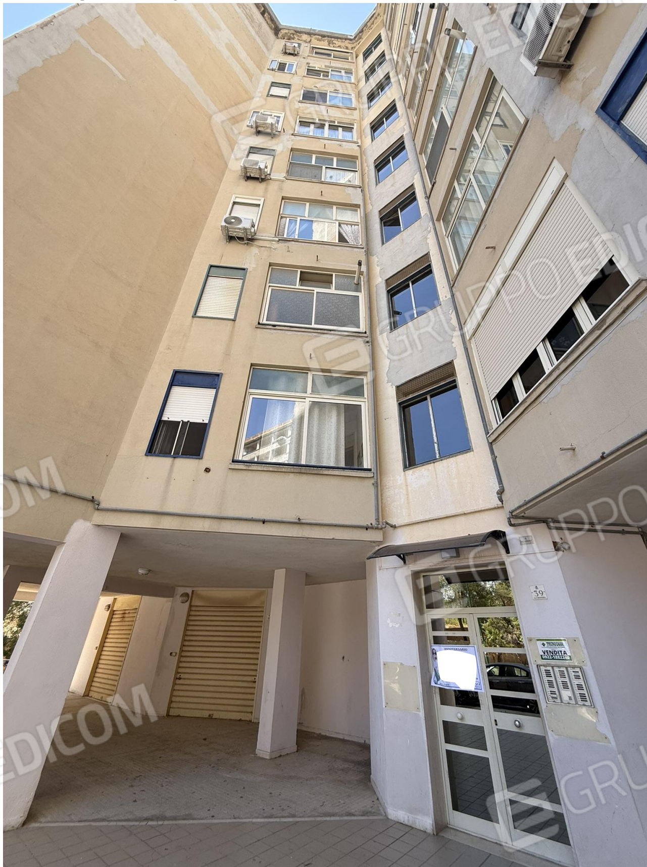
Foto 2 – Prospetto esterno ingresso stabile
