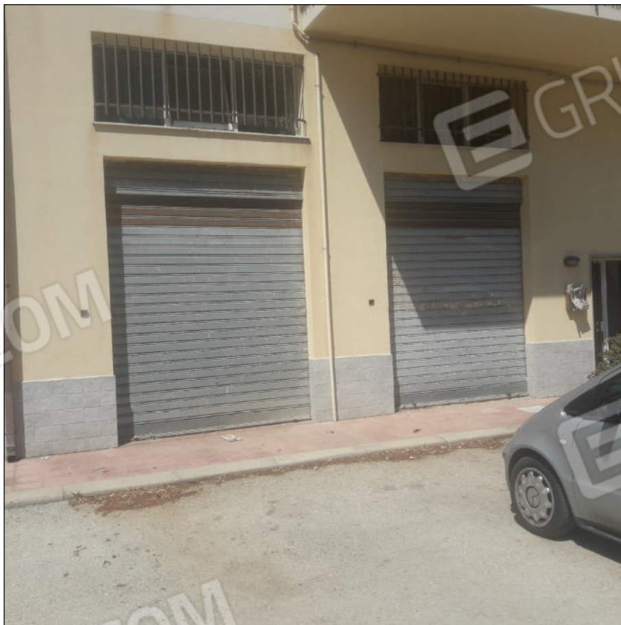
Prospetto sud (prime due saracinesche)
