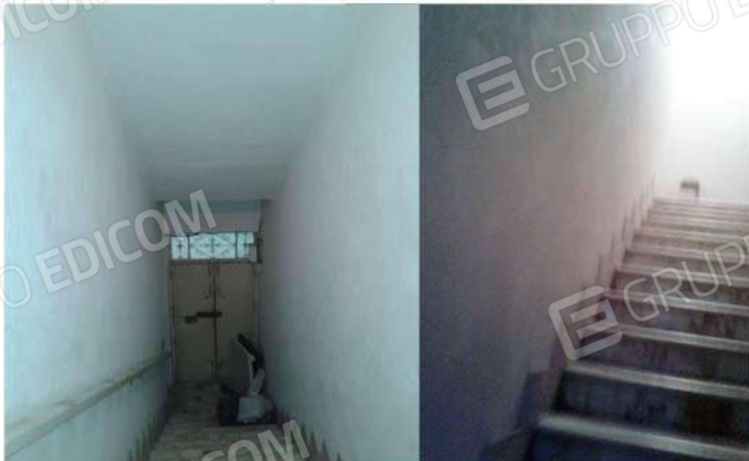
FOTO 6 E 7) PRIMA RAMPA DI SCALE DI ACCESSO AL PIANO PRIMO
