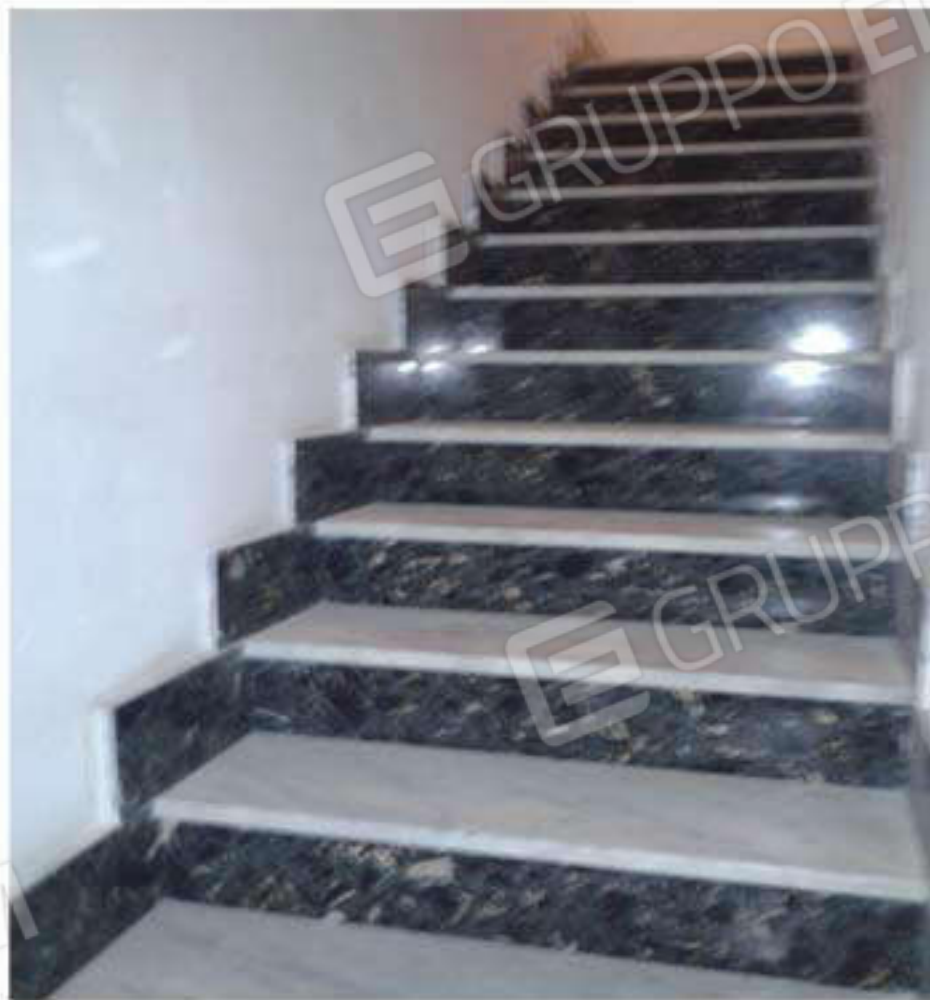
Foto 12) Scala di accesso al piano secondo
