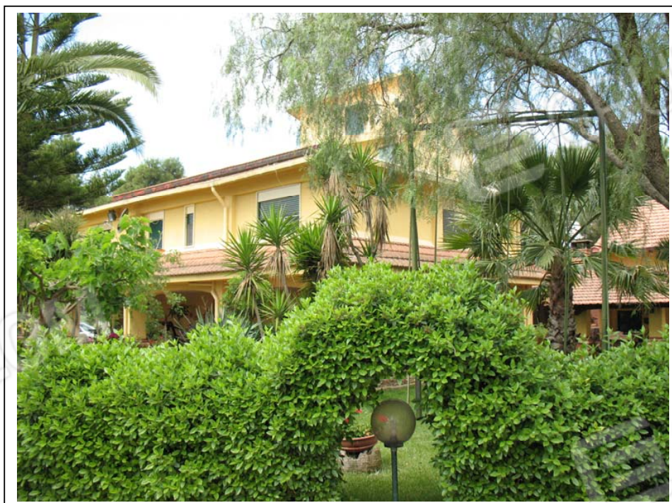
Rilievo Fotografico – Fabbricato principale - esterni
