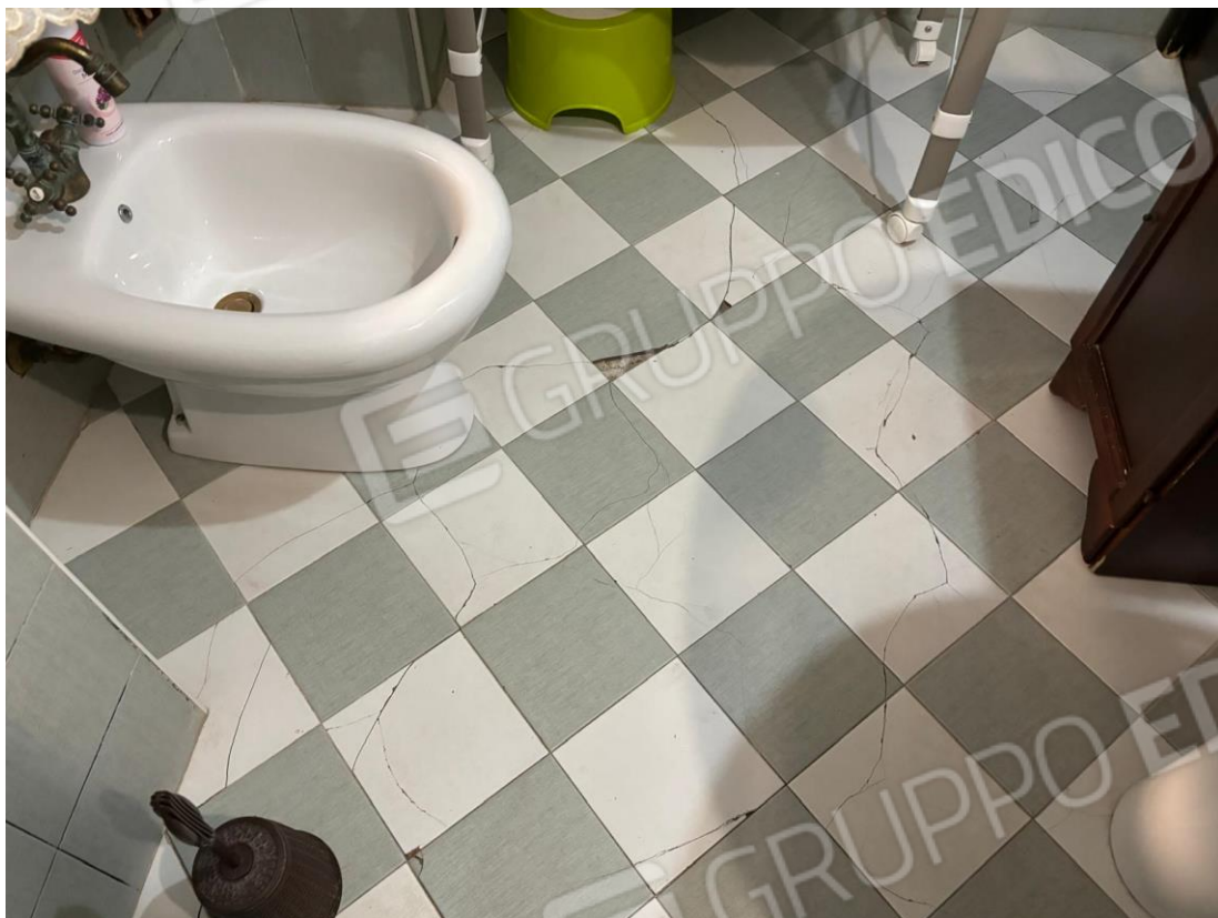
Foto n. 7 – Altra vista del bagno dell'unità immobiliare con il particolare di alcune lesioni superficiali del pavimento
