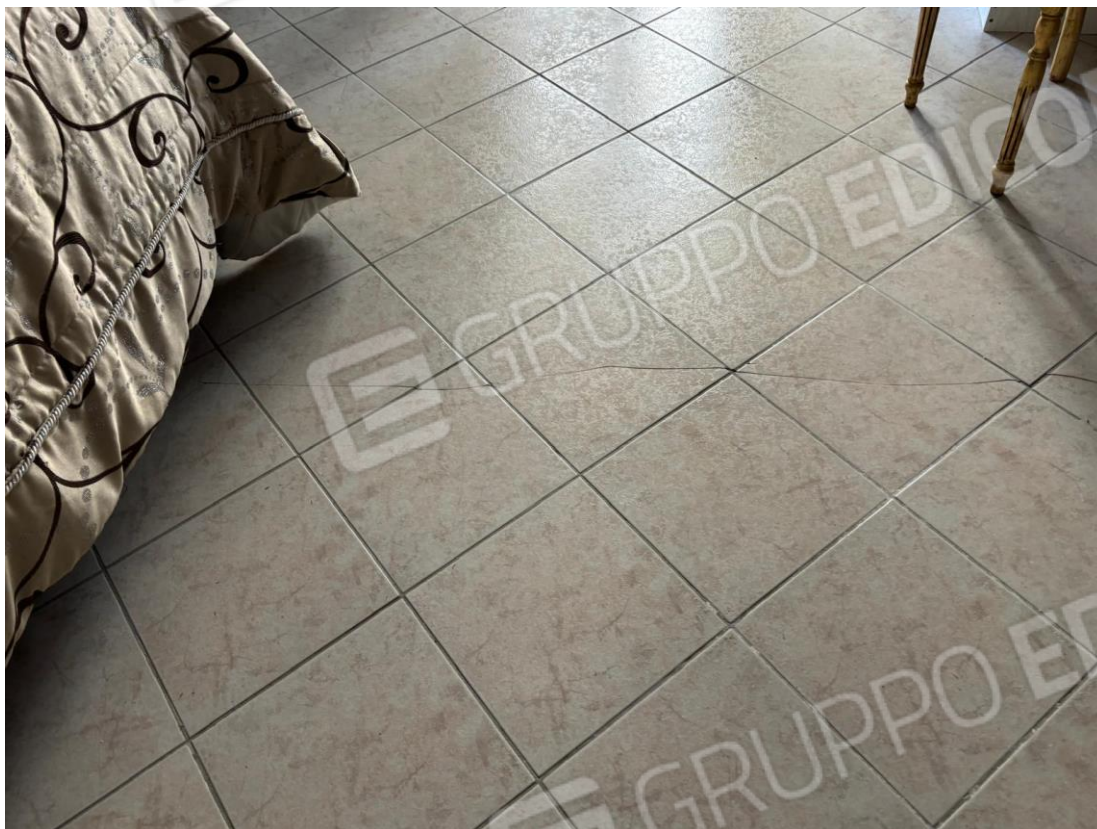
Foto n. 11 – Particolare di alcune lesioni superficiali del pavimento della camera da letto, posta al piano primo dell'unità immobiliare
