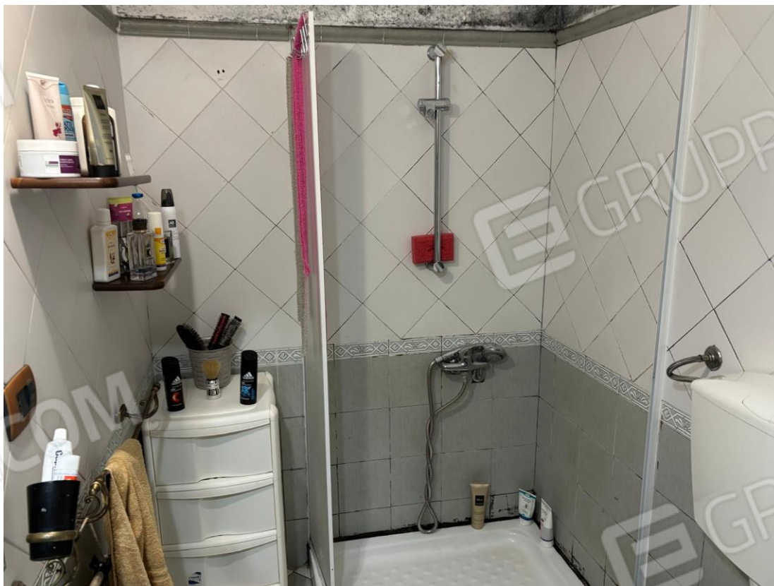
Foto n. 6 – Vista del bagno dell'unità immobiliare
