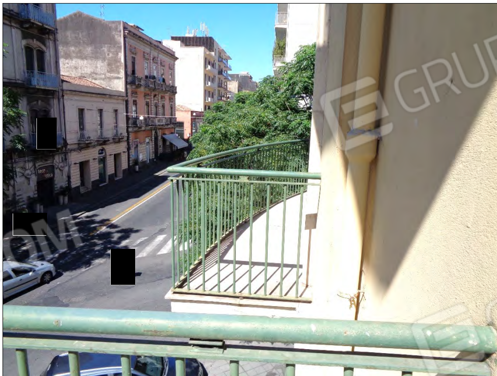
FOTO N° 14 – BENE “A” – BALCONE
