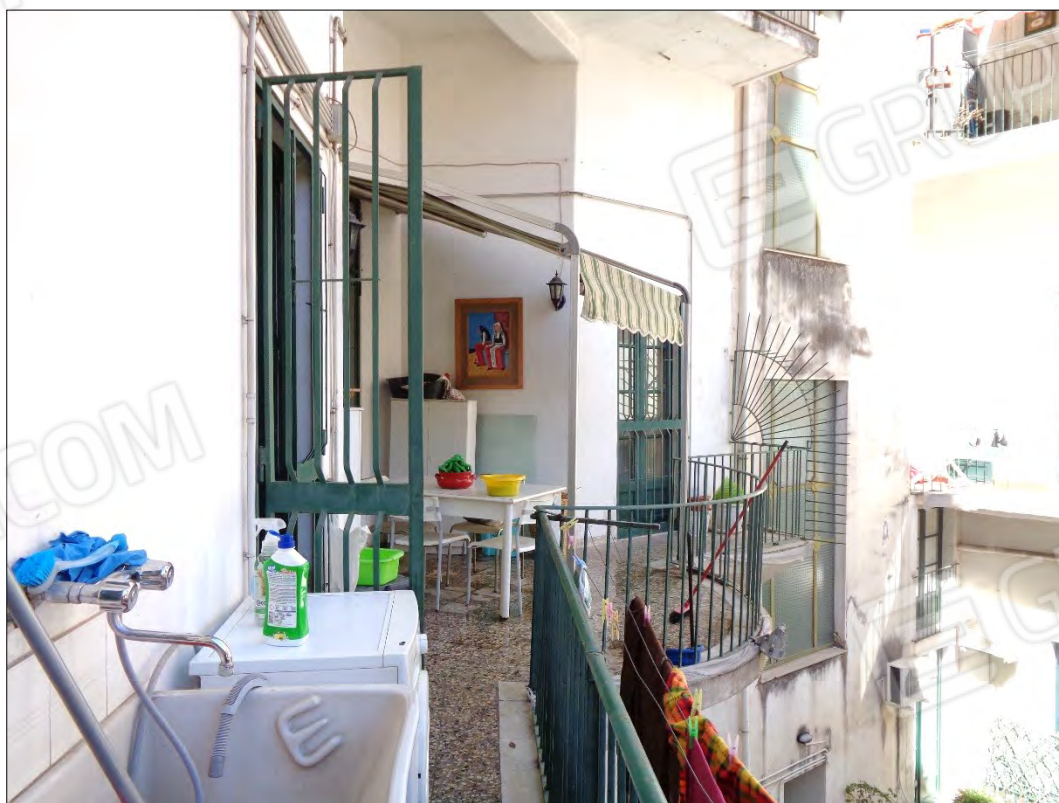
FOTO N° 4 – BENE “A” – BALCONE
