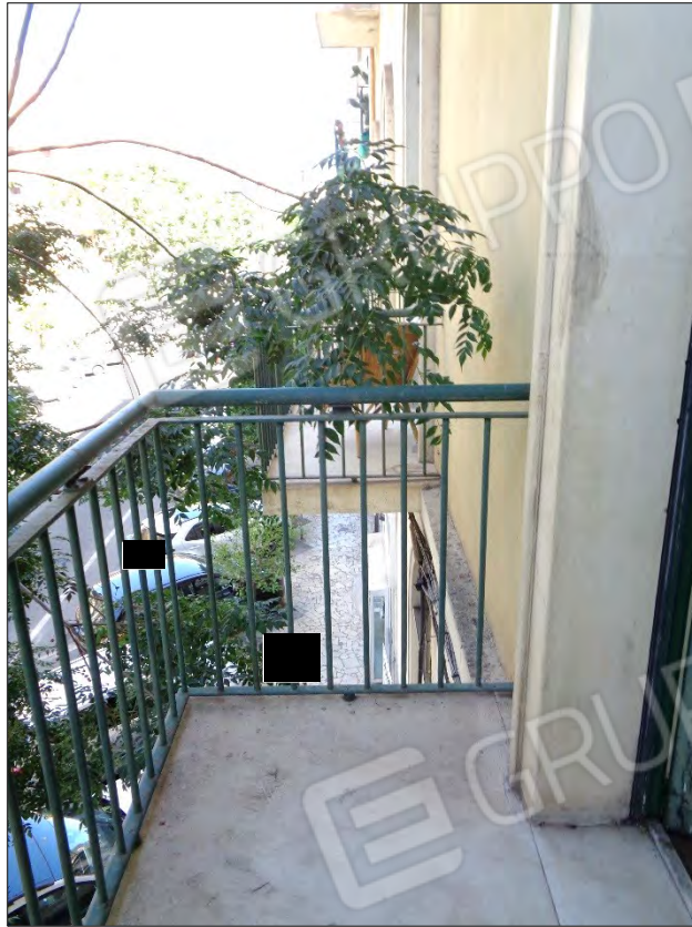
FOTO N° 11 – BENE “A” – BALCONE
