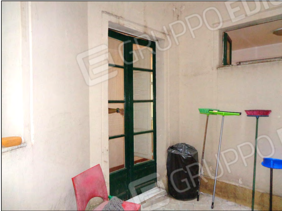
FOTO N° 45 – BENE “B” – TERRAZZINO (POZZO LUCE)
