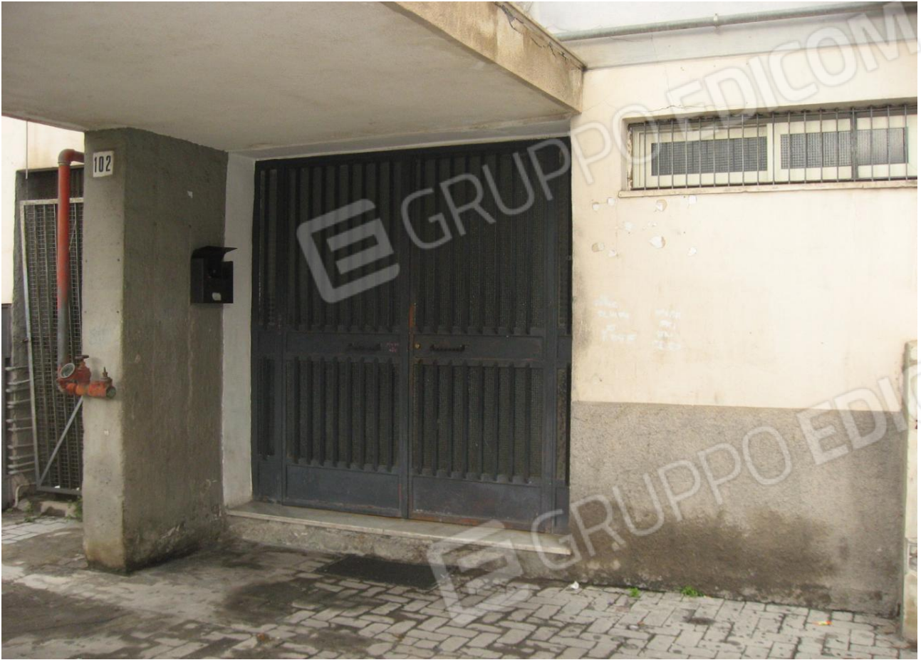
FO 3: Ingresso condominiale.
