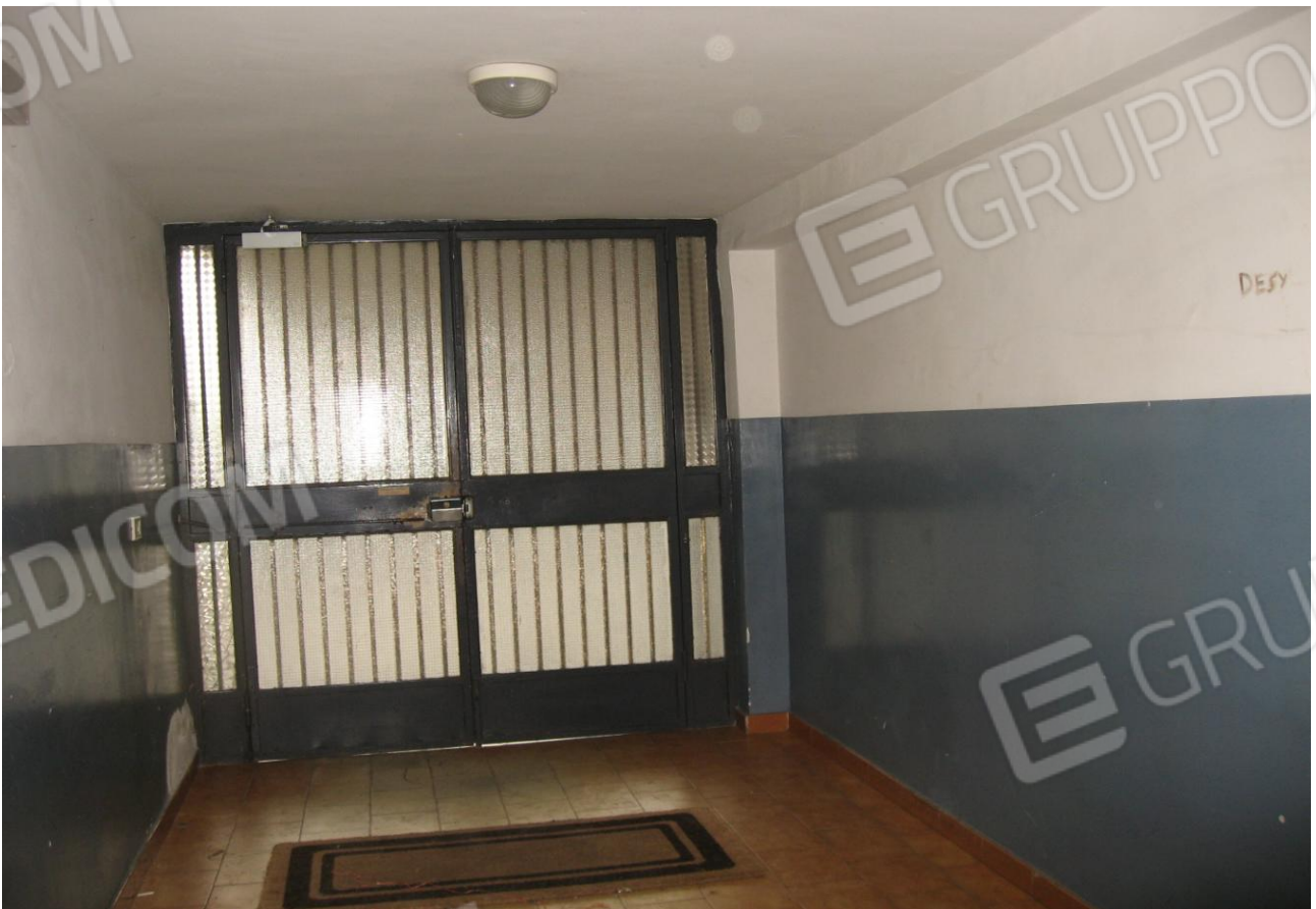
FO 4: Androne condominiale.
