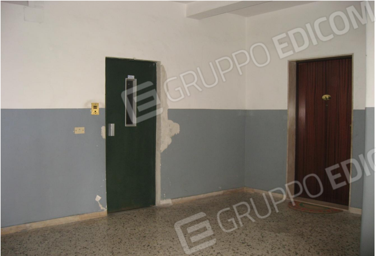
FO 5: Pianerottolo comune.
