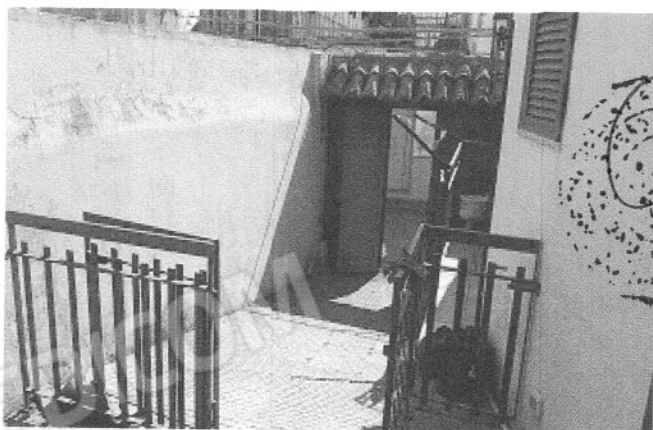
Foto n°3- vista panoramica del cortile verso il passo Carraio;
