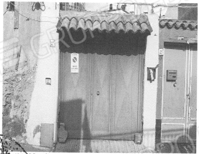
Foto n°2-vista esterna passo carraio;
