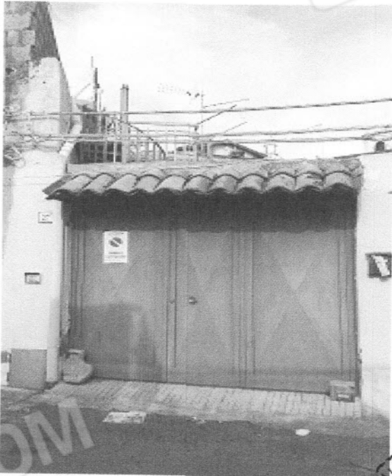
Foto n°1-vista prospetto esterno immobile e del passo carraio d'ingresso;
