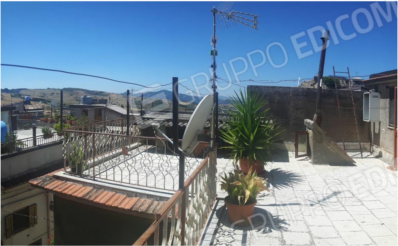
Foto 32 – Terrazza di copertura
