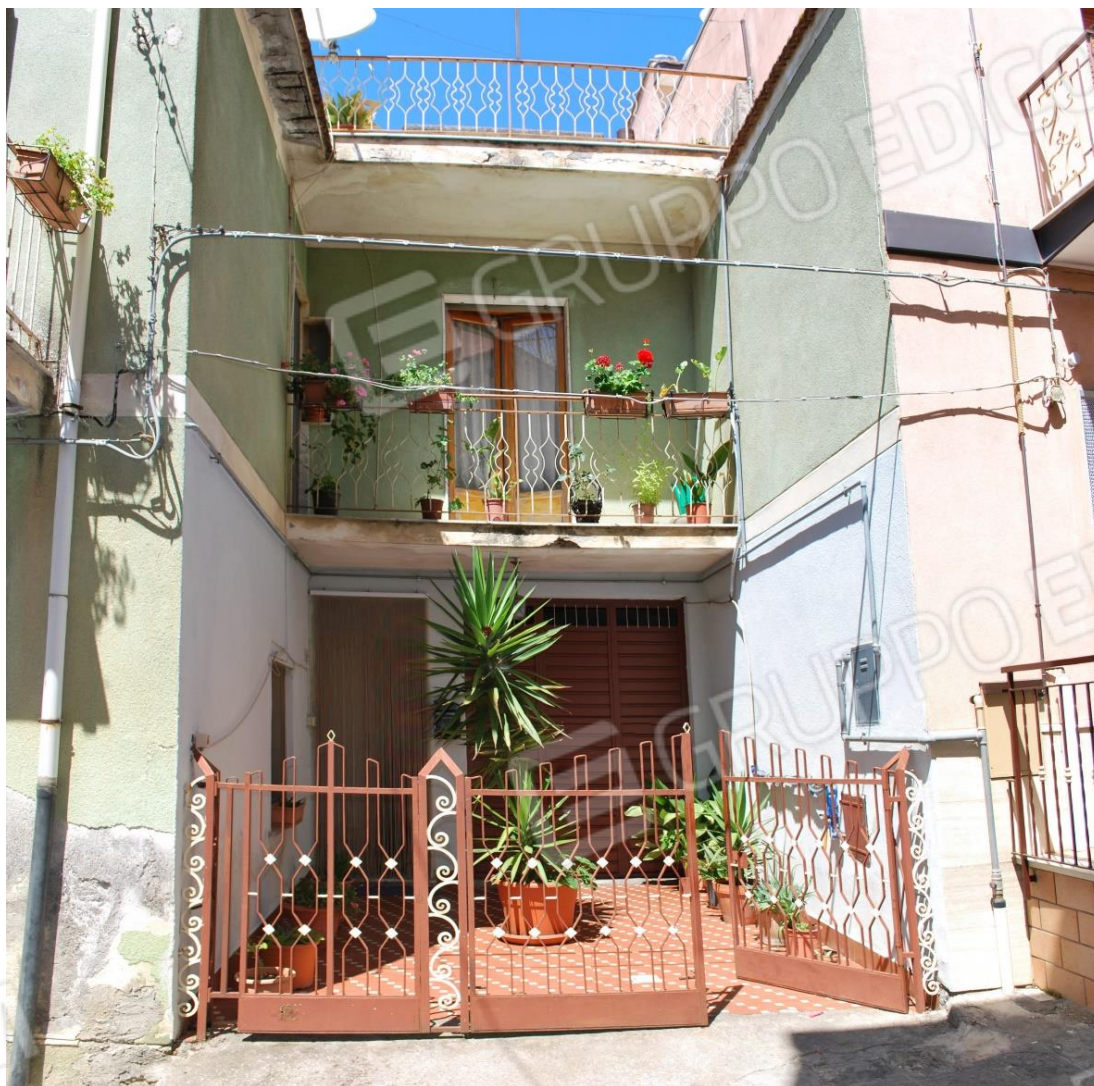
Foto 4 – Vista degli ingressi dei due immobili dalla via S. Michele
