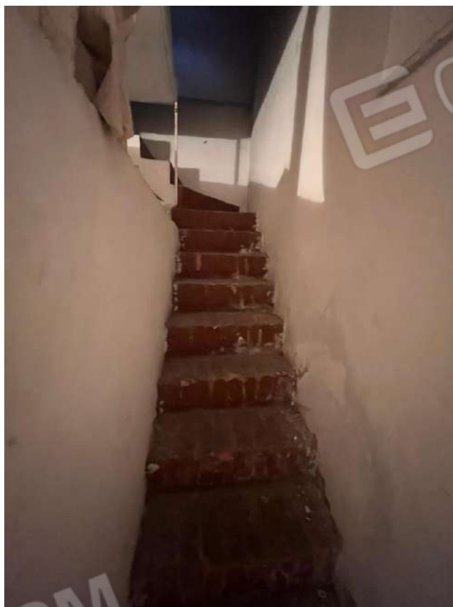
16. Scale accesso al terrazzo di copertura
