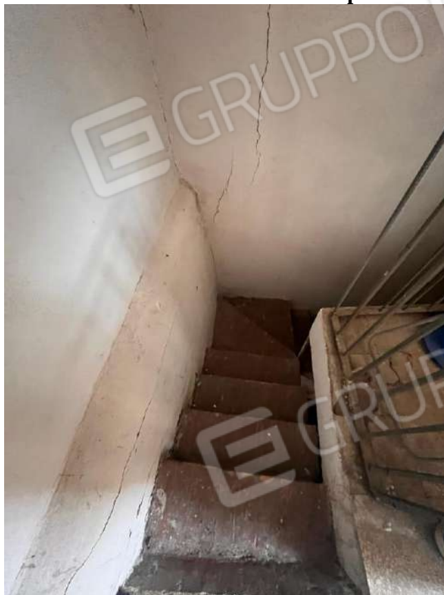
17. Scale accesso al terrazzo di copertura
