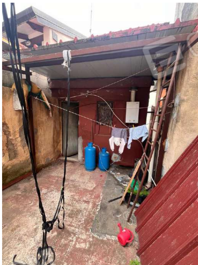
20. Vista vano sul terrazzo di copertura
