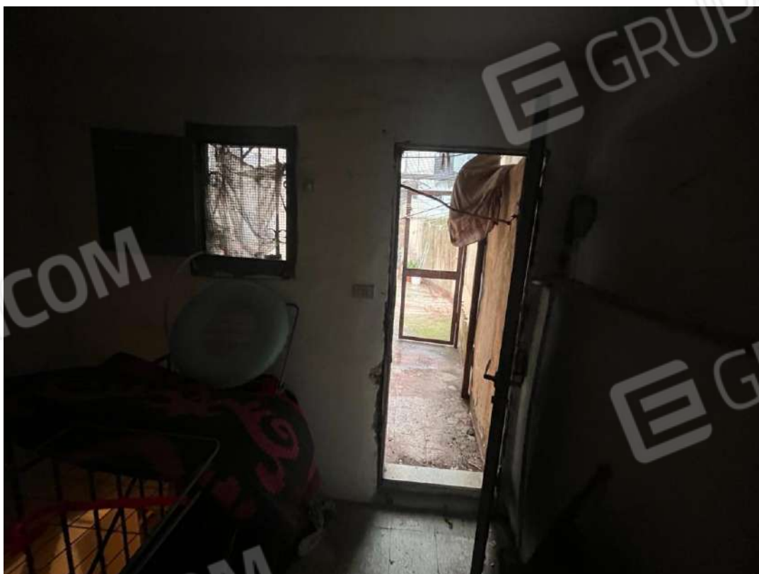
18. Locale – vano scala – piano copertura
