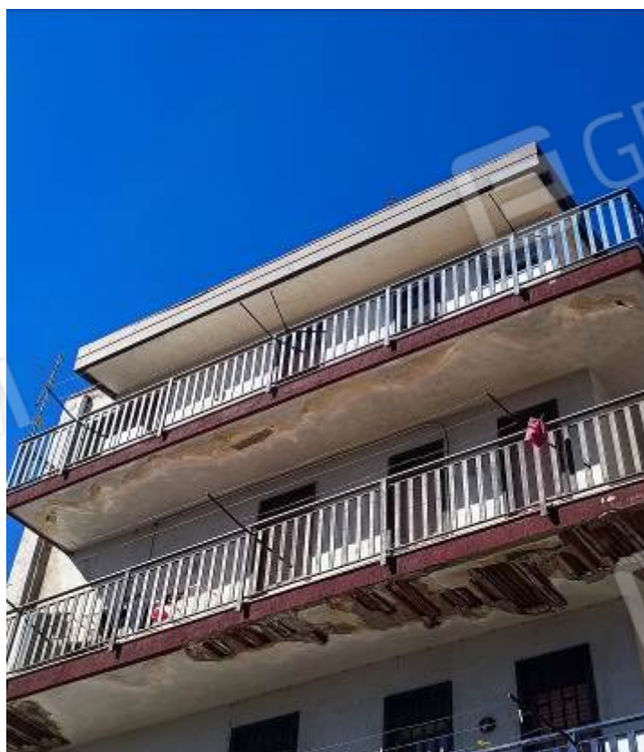
Foto 18 – Lo stabile a cui appartiene l'immobile pignorato: prospetti
