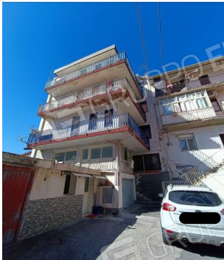
Foto 15 – Lo stabile a cui appartiene l'immobile pignorato: prospetti
