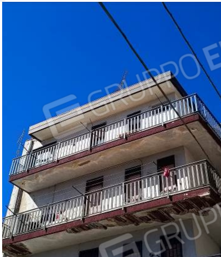
Foto 17 – Lo stabile a cui appartiene l'immobile pignorato: prospetti
