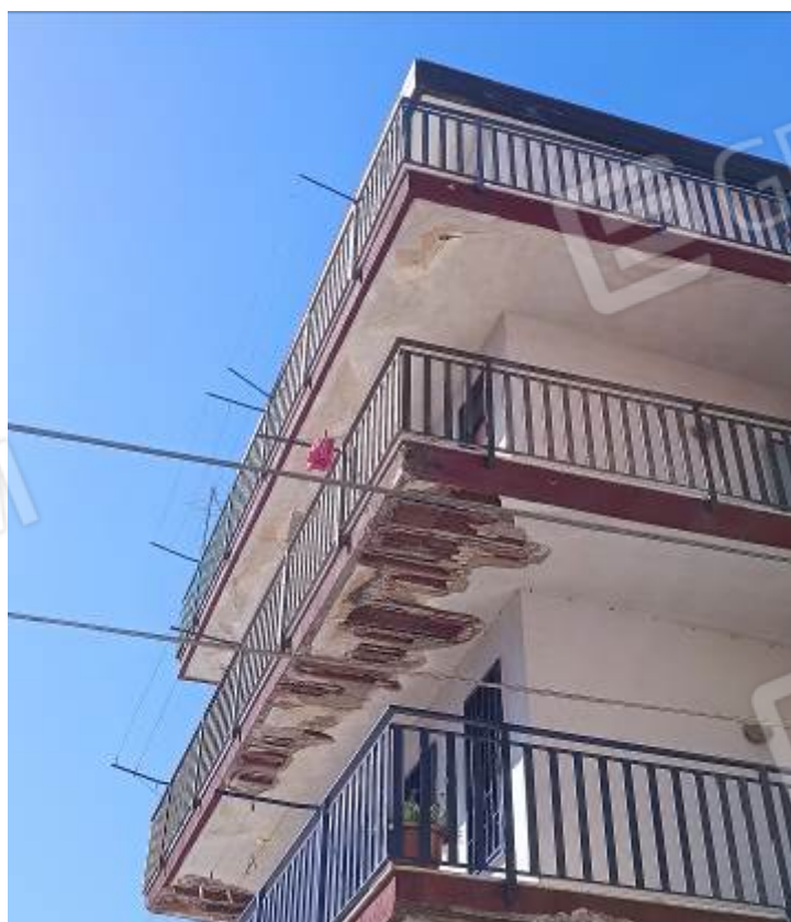
Foto 20 – Lo stabile a cui appartiene l'immobile pignorato: prospetti
