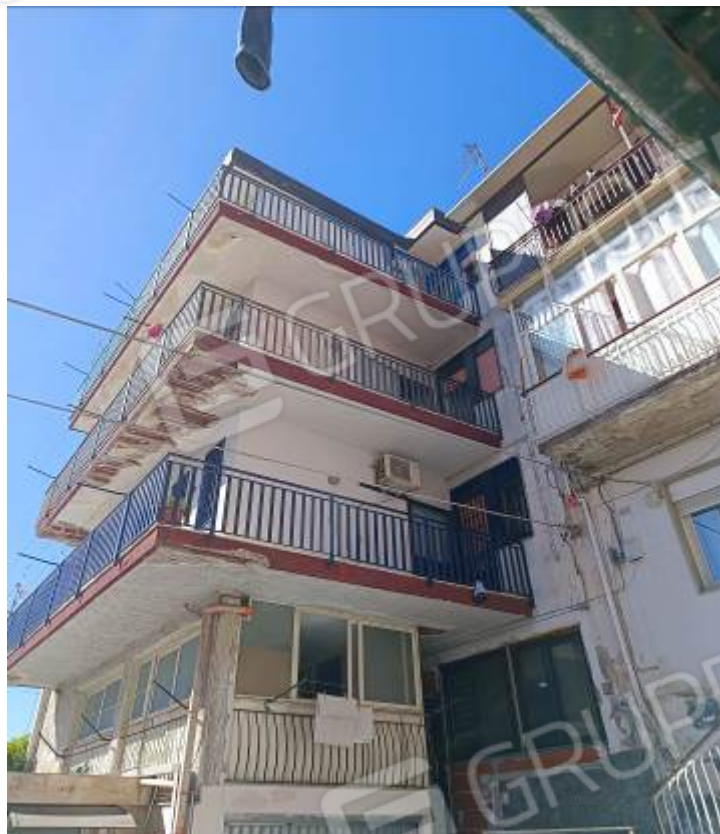
Foto 19 – Lo stabile a cui appartiene l'immobile pignorato: prospetti
