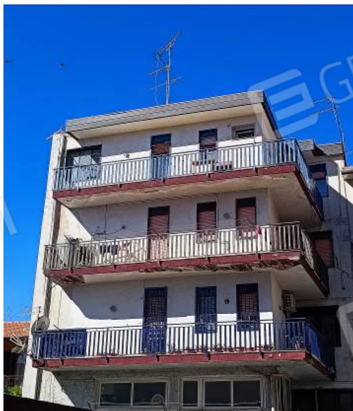
Foto 16 – Lo stabile a cui appartiene l'immobile pignorato: prospetti
