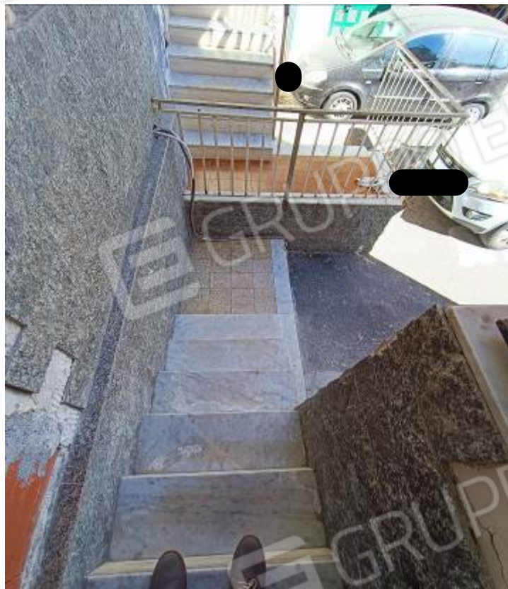
Foto 21 – Accesso dal cortile comune al vano scala che conduce all'appartamento pignorato
