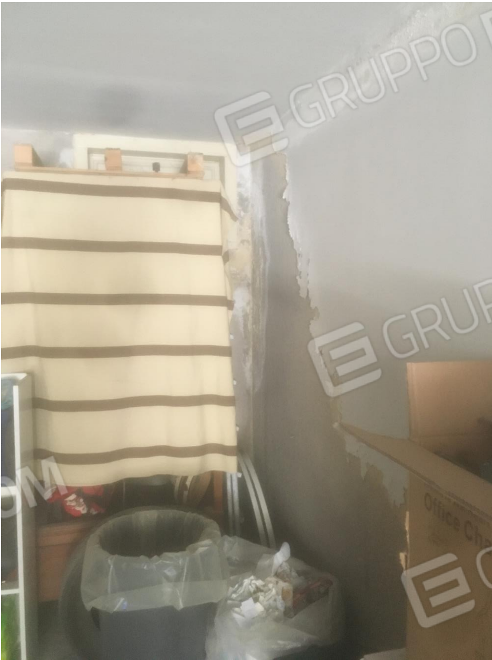
FO-30 danni da umidità garage scala B edificio B piano seminterrato
