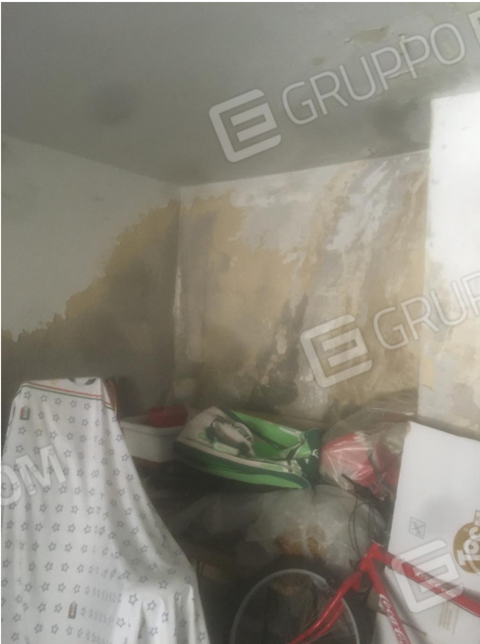
FO-32 danni da umidità garage scala B edificio B piano seminterrato
