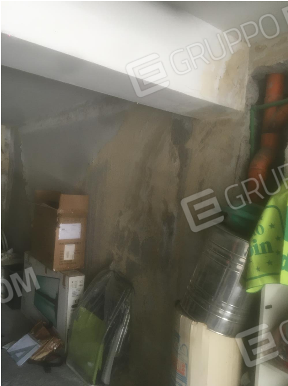
FO-29 danni da umidità garage scala B edificio B piano seminterrato
