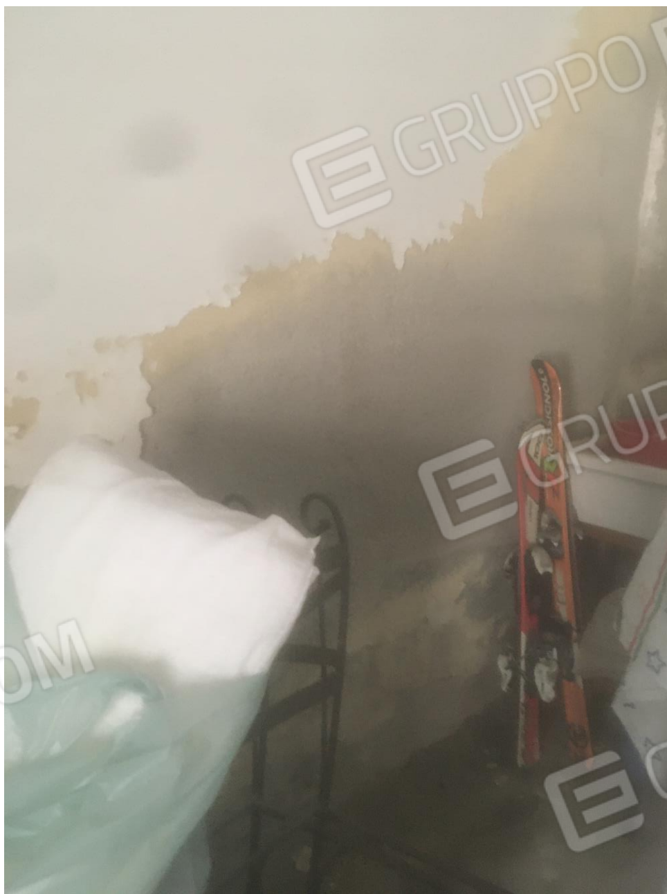
FO-33 danni da umidità garage scala B edificio B piano seminterrato
