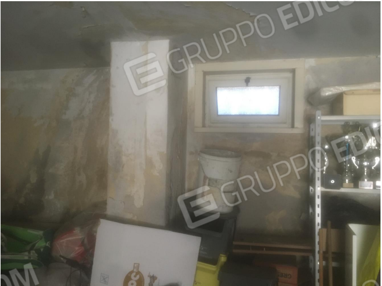
FO-31 danni da umidità garage scala B edificio B piano seminterrato
