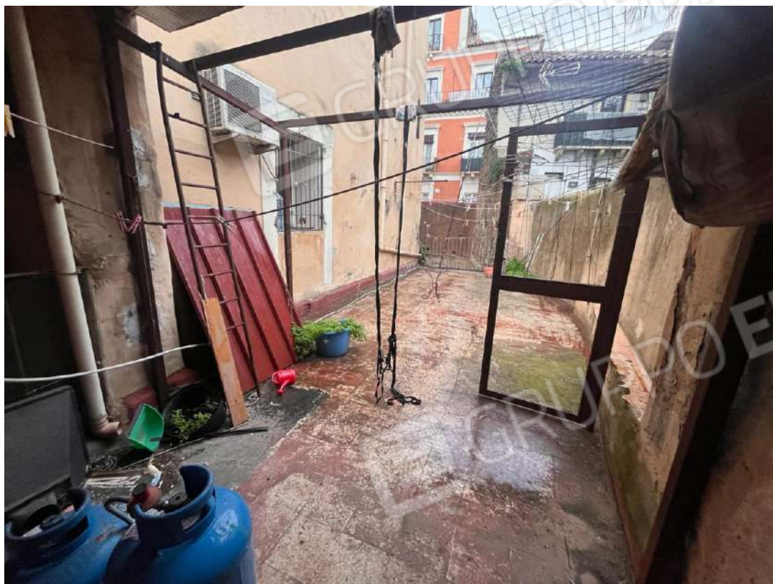
19. Terrazzo di copertura abitazione
