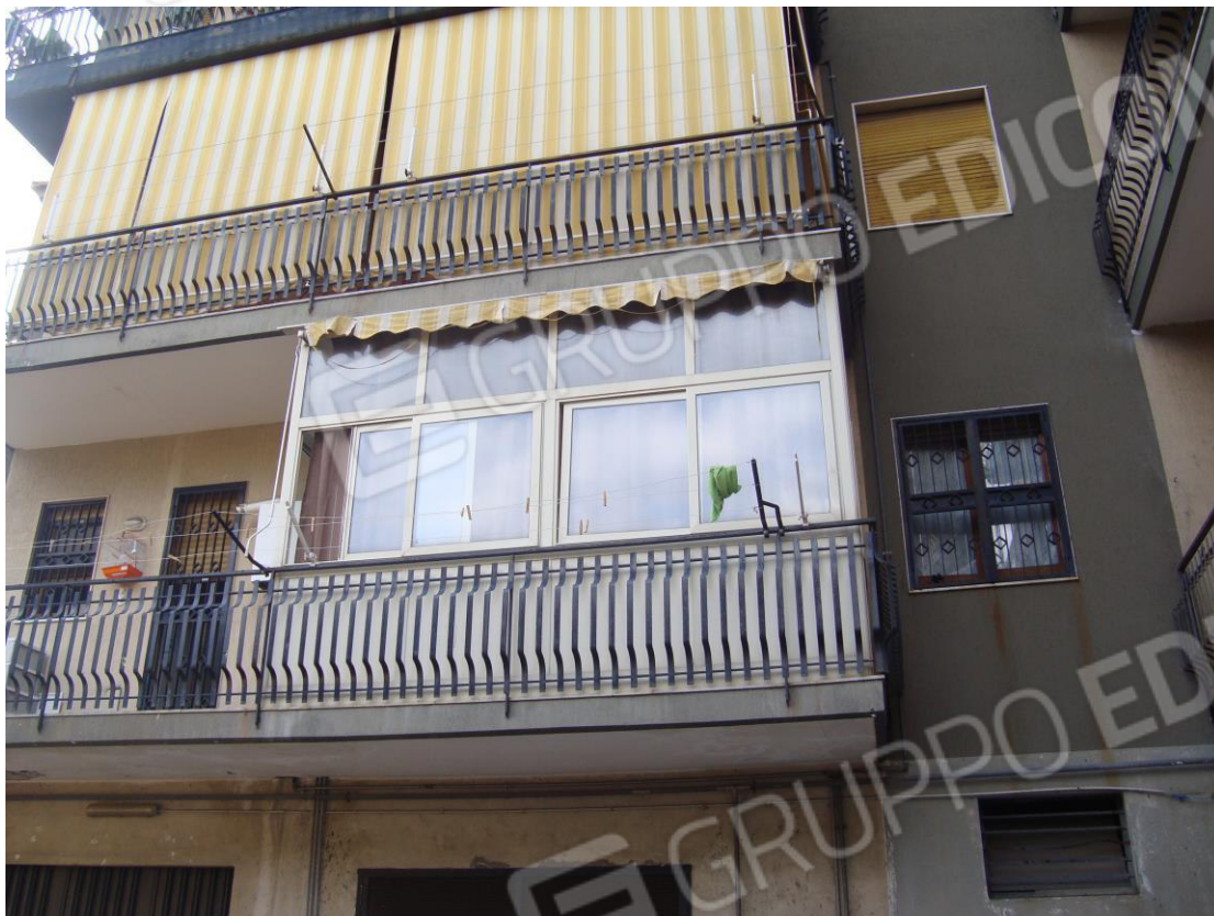
Foto 31 – Balcone interno e veranda
