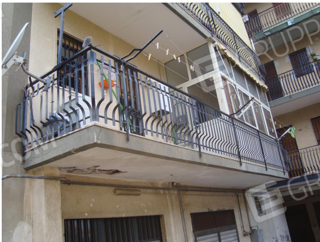
Foto 30 – Balcone interno veranda
