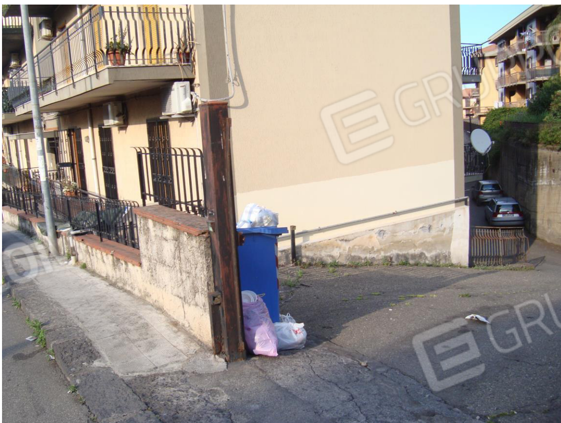
Foto 28 – Vista lato Sud da via IV Novembre
