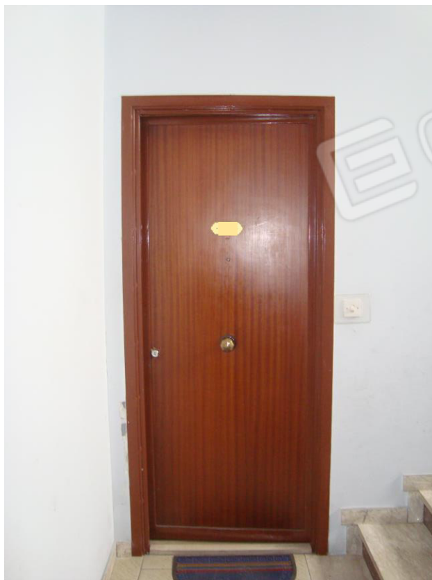
Foto 6 – Porta di ingresso (da vano scala)
