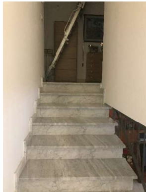
-Foto 7 (particolare scala piano secondo)
