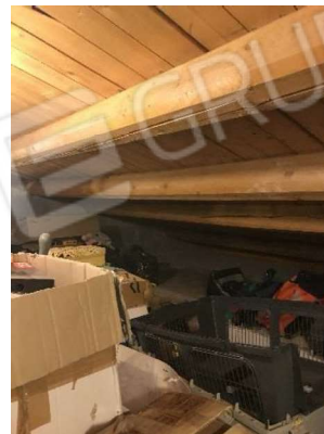
-Foto 12 (particolare sottotetto)
