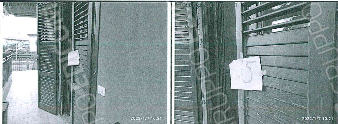
INGRESSO DA BALLATOIO APPARTAMENTO SUB 5
