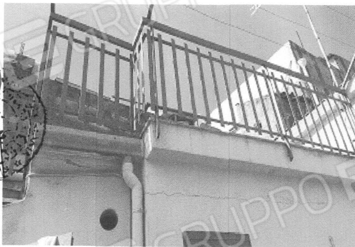
Foto n°2-vista panoramica del terrazzo;
