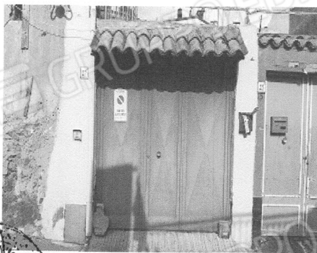
Foto n°2-vista esterna passo carraio;
