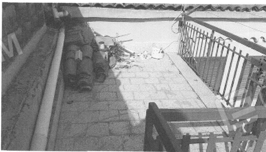
Foto n°3-vista panoramica del terrazzo;
