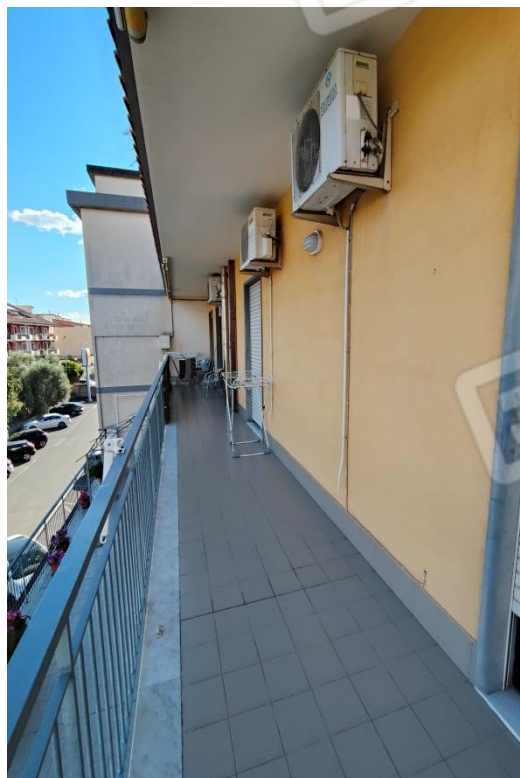
FOTO 22-23: Balcone verso spazio esterno
