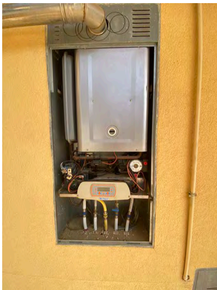
FOTO 24– VISTA DELLA CALDAIA ESTERNA
