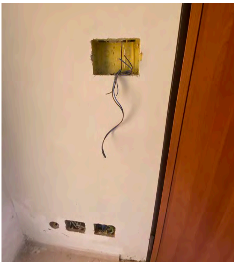
FOTO 12 – PARTICOLARE DELL'IMPIANTO ELETTRICO NON COMPLETO
