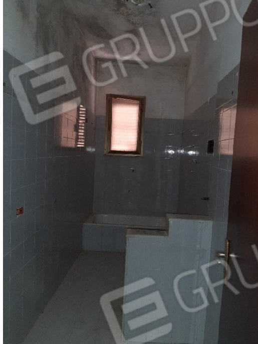
Foto 9 - Vista interna dell'immobile
