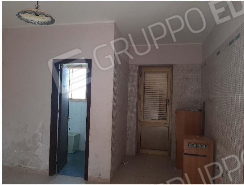
Foto 5 – Interno del fabbricato
