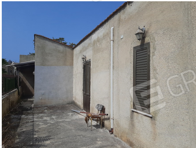
Foto 2 – Vista lato sud-est dell'immobile
