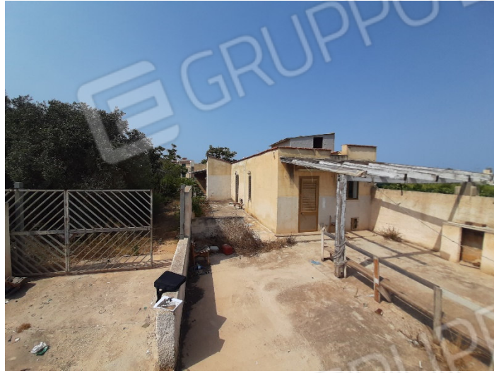
Foto 1- Vista d'insieme del fabbricato oggetto di stima
