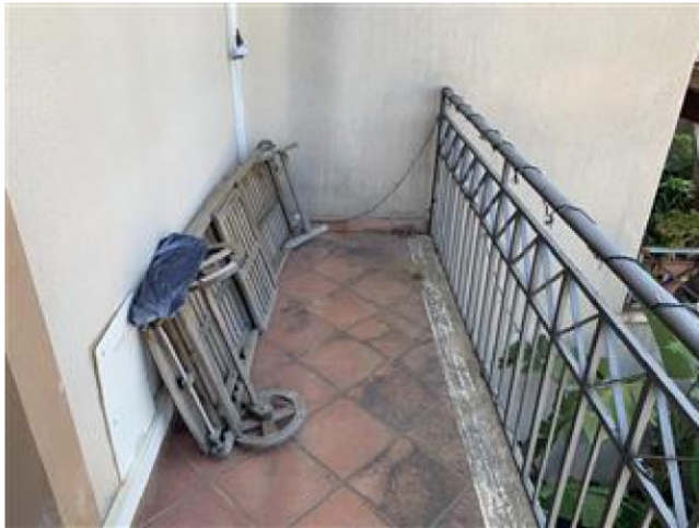
foto n. 17: piano primo - balcone
