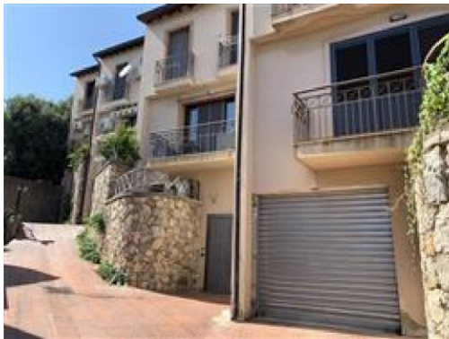
foto n. 03: ingresso al piano cantinato dalla strada condominiale
