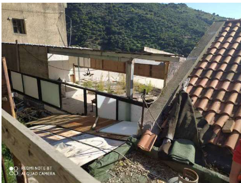
Foto n° 44 – Tettoia fronte retro
