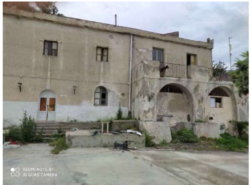
Foto n° 17 – Fabbricato e corte, (prospetto principale)
