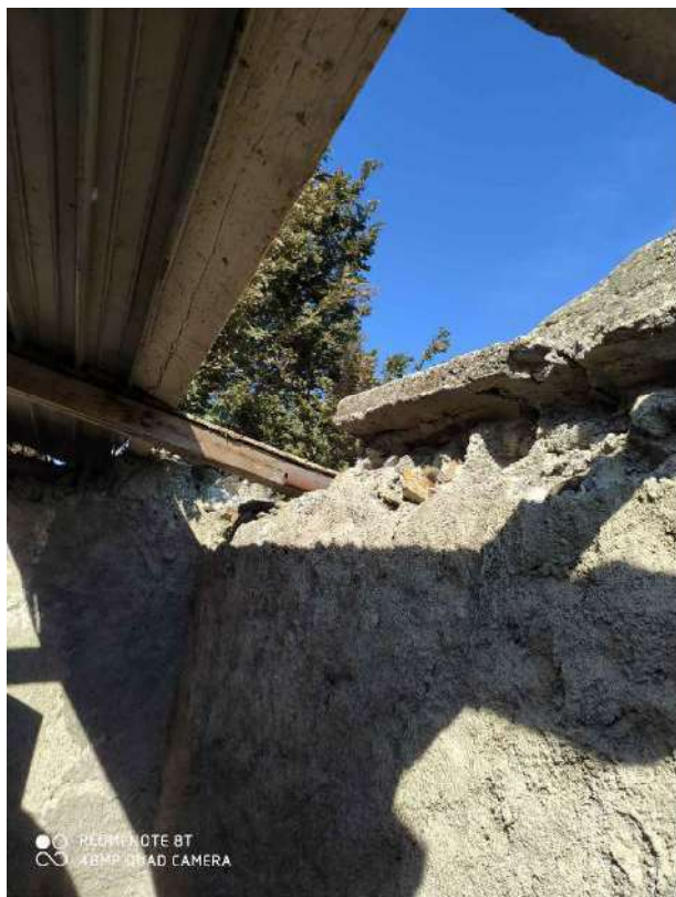
Foto n° 41 – Deposito (Particolare del tetto)
