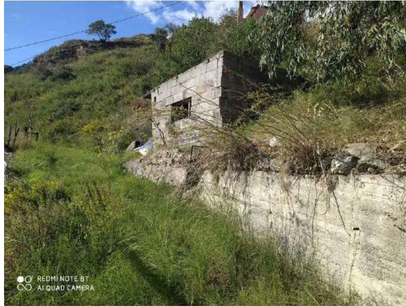
Foto n° 38 – Deposito e tratto del fondo
