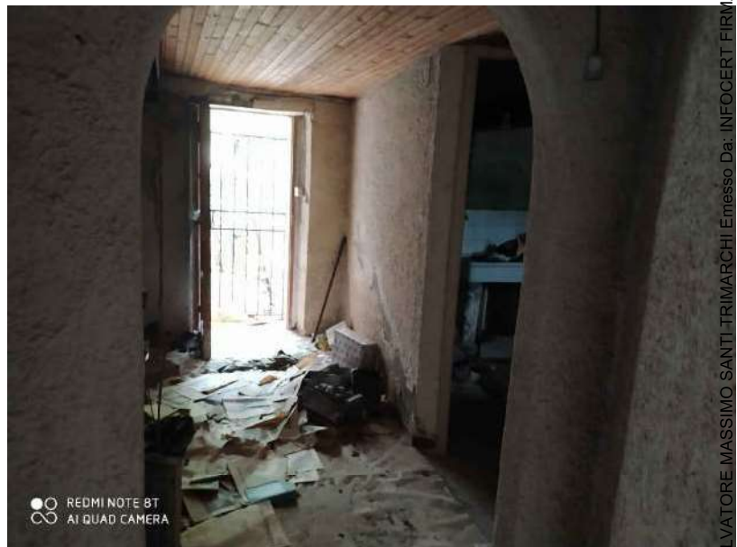
Foto n° 32 – disimpegno zona di servizio (cucina, wc)
