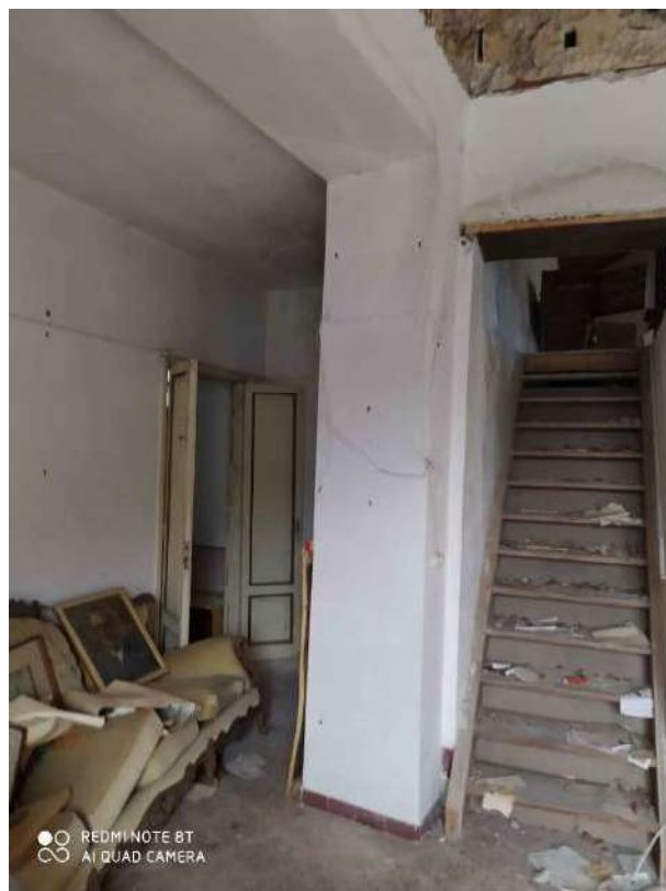
Foto n° 26 – scala di accesso alla soffitta
