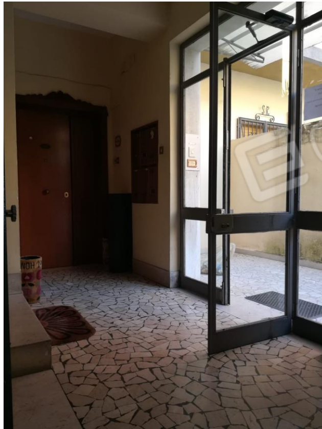
Foto n. 20: Portone di ingresso via Setaioli;
