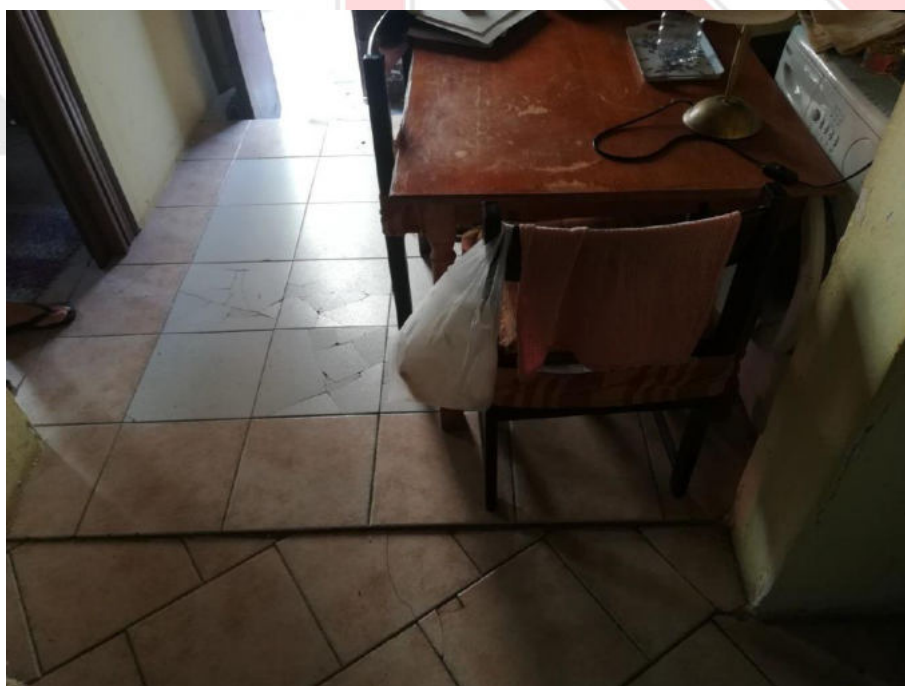
FOTO 7 – CONDIZIONI INTERNE DEL FABBRICATO
