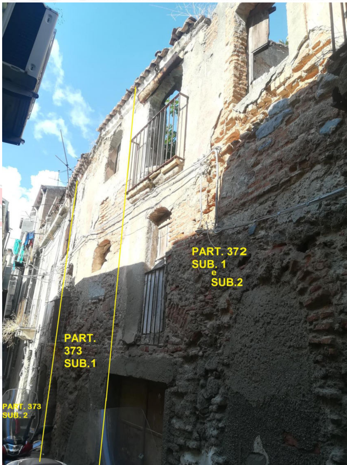
FOTO 13 – PROSPETTO PRINCIPALE DEL FABBRICATO 373 SUB. 1
