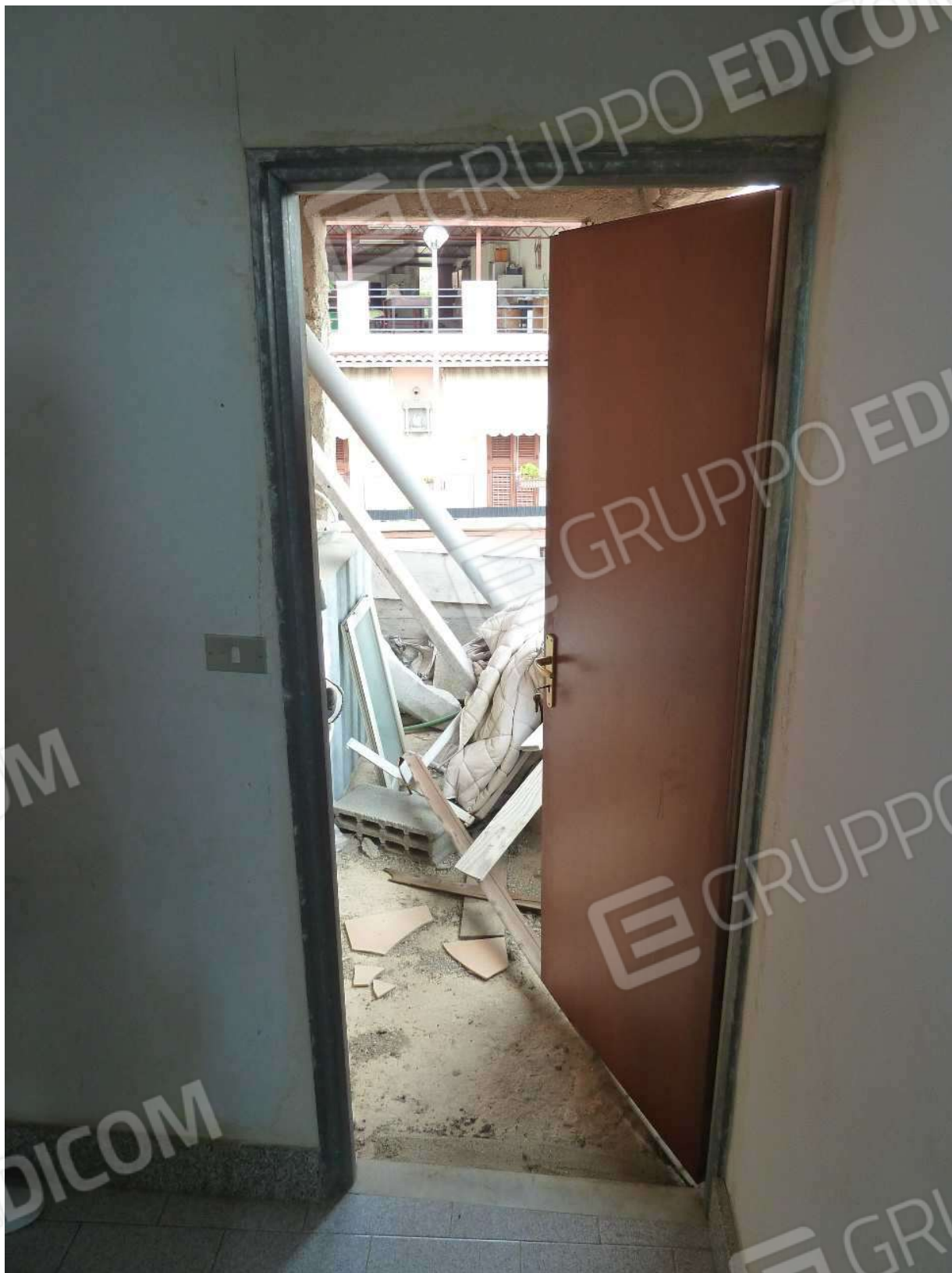
Ingresso locale deposito, vista dal pianerottolo d'ingresso.
