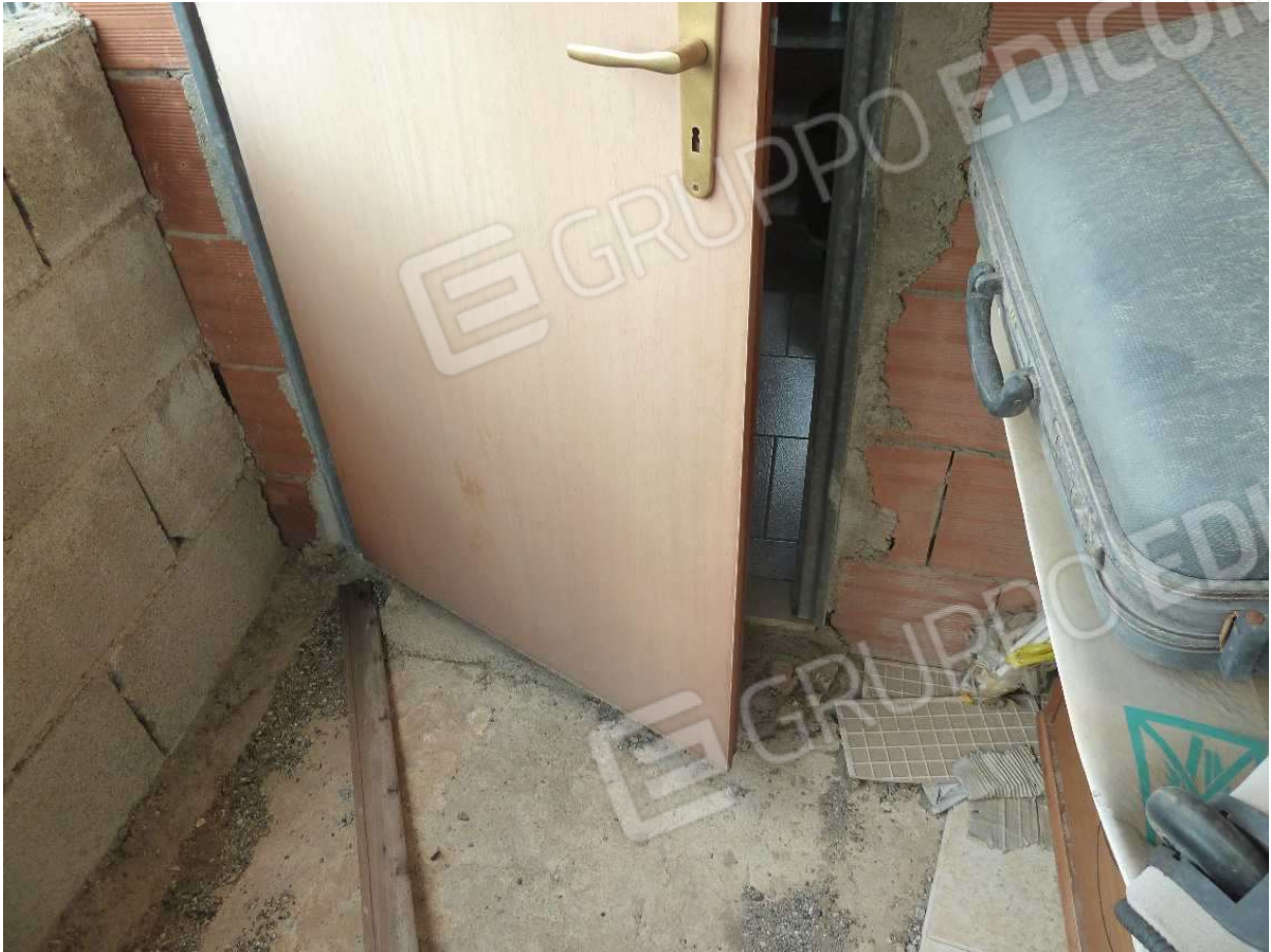
Locale deposito, particolare.
