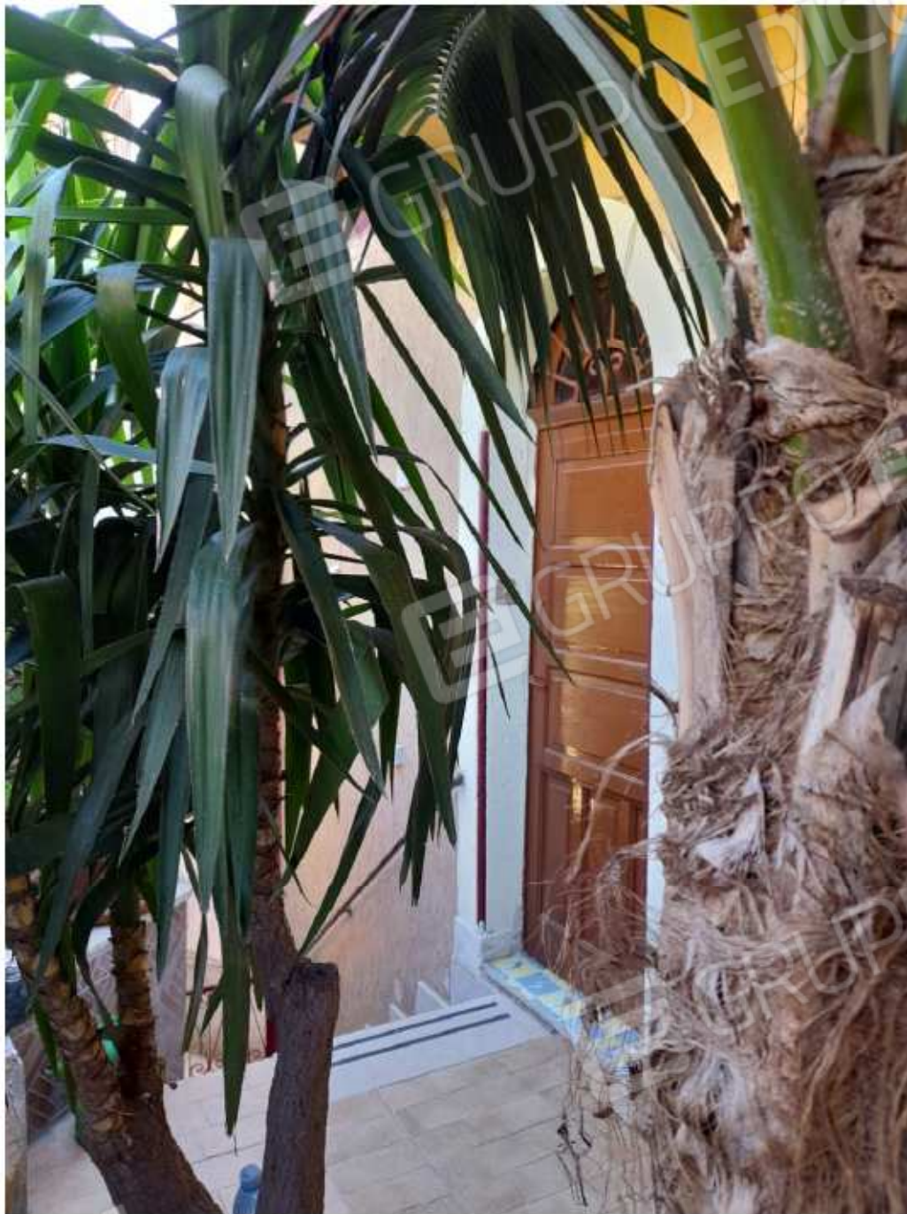
-Foto n.9: Portoncino secondario dell'immobile, adiacente al principale-
