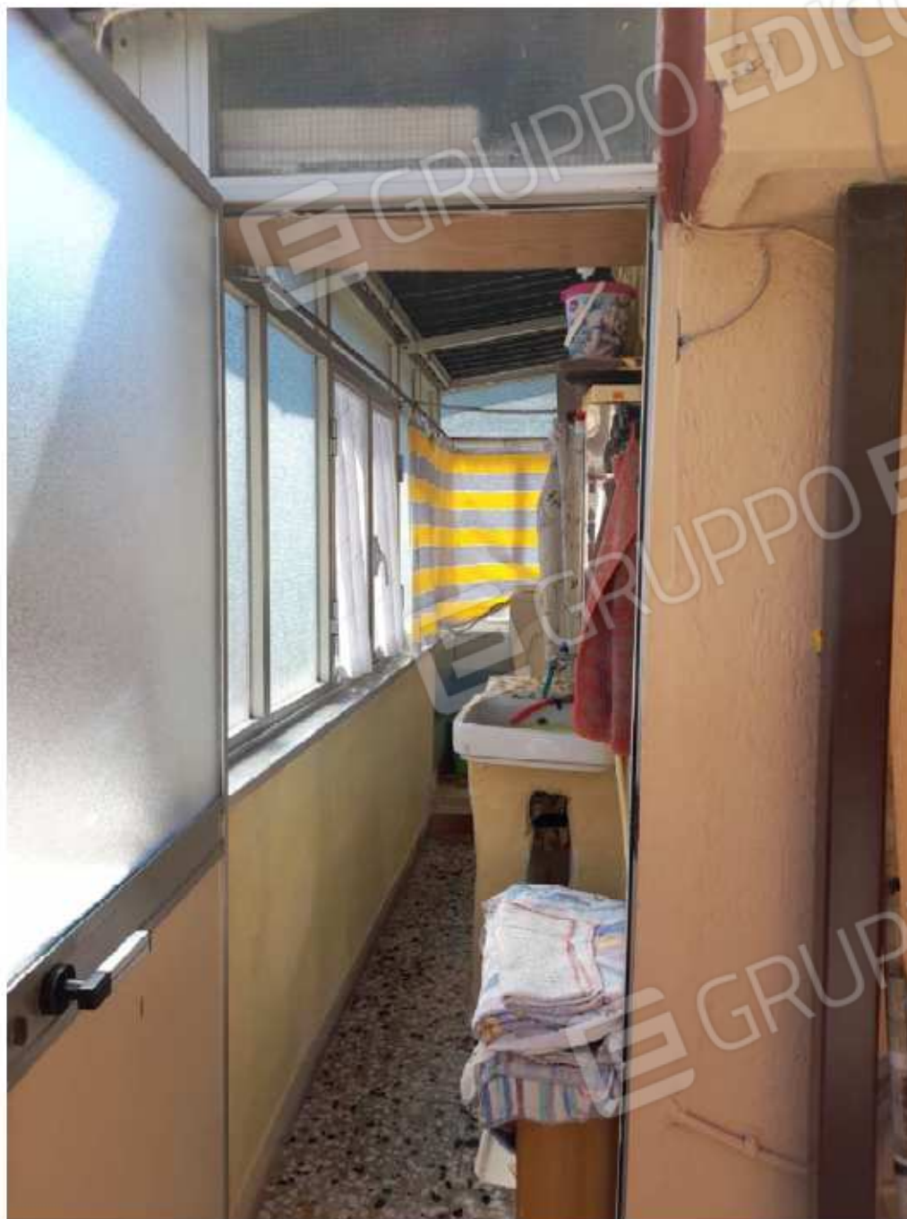
-Foto n.27: Vano ripostiglio esterno (prospetto NO) -
