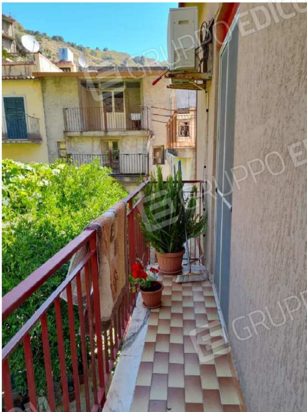
-Foto n.22: prosecuzione del balcone sul prospetto NE ove si affaccia il vano letto 1-
