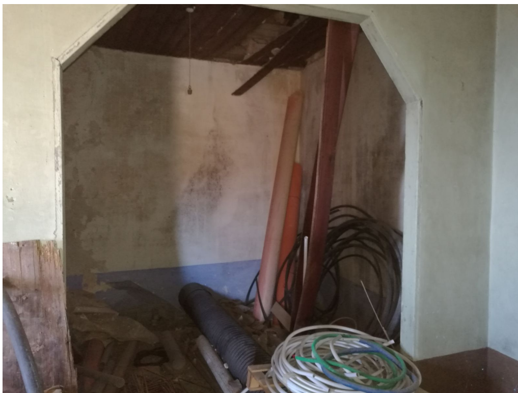
Foto: Fg. n° 33 p.lla n° 332 sub 4
