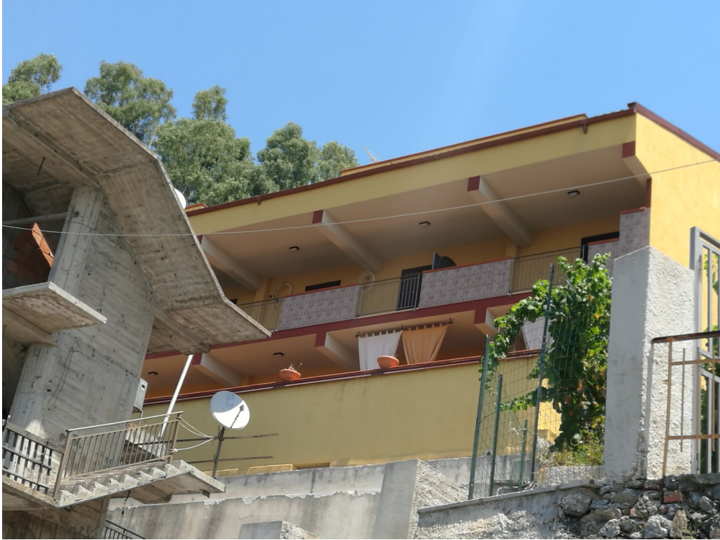
1 - vista esterna del fabbricato Fg. n° 34 p.lla n° 347
