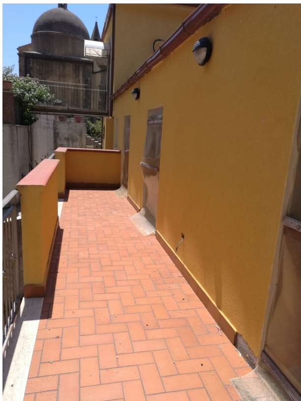
Foto: Fg. n° 34 p.lla n° 347 sub 10
