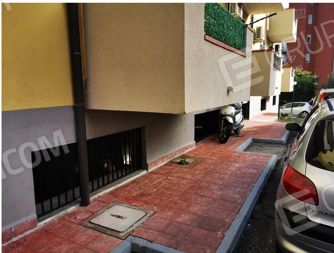
FOTO n. 4 – Lato sud- Finestre lucifere del deposito
