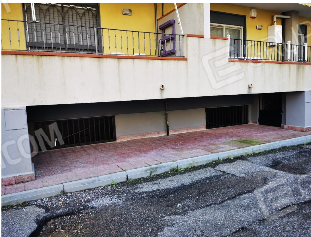
FOTO n. 8 – Prospetto nord- finestre lucifere del magazzino
