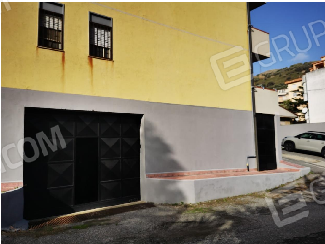
FOTO n. 10 – Portone ingresso deposito
