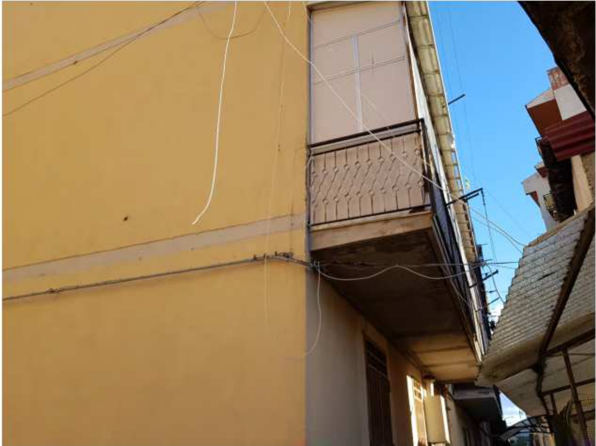
Figura 1 Vista balcone lato ovest
