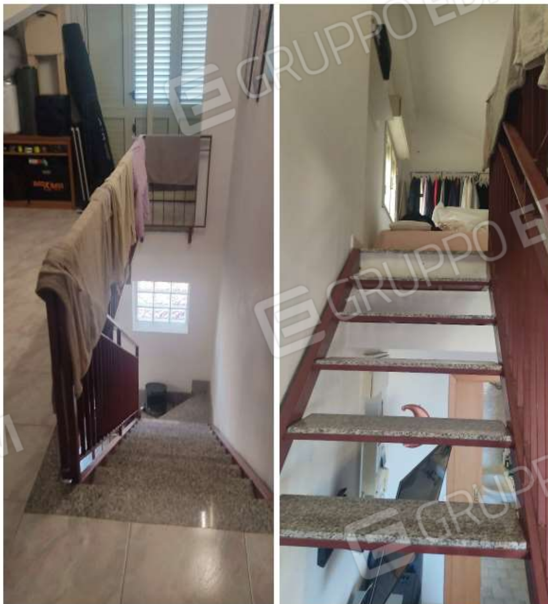
SCALA INTERNA DI COLLEGAMENTO TRA L'APPARTAMENTO (PIANO 2) E LA MANSARDA (PIANO 3)
