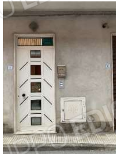
Foto 3 “Ingresso all’unità immobiliare”
