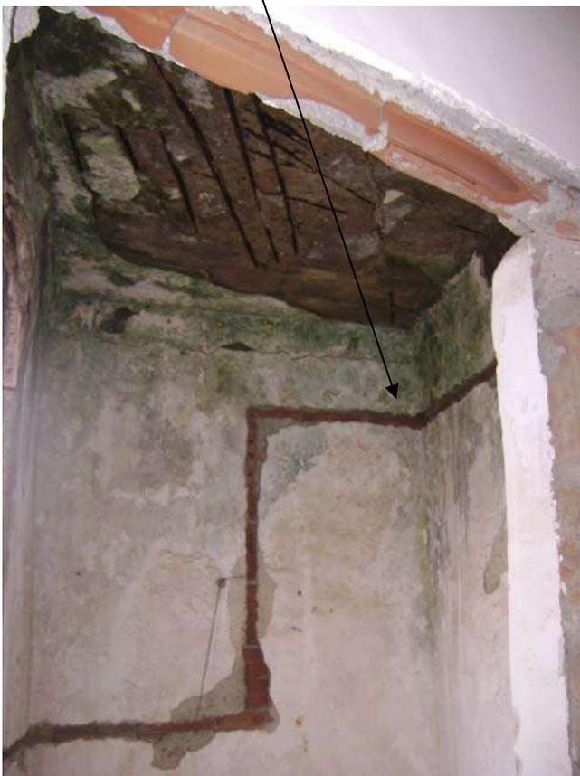
*si noti lo stato dei ferri d'armatura in corrispondenza del tetto*
