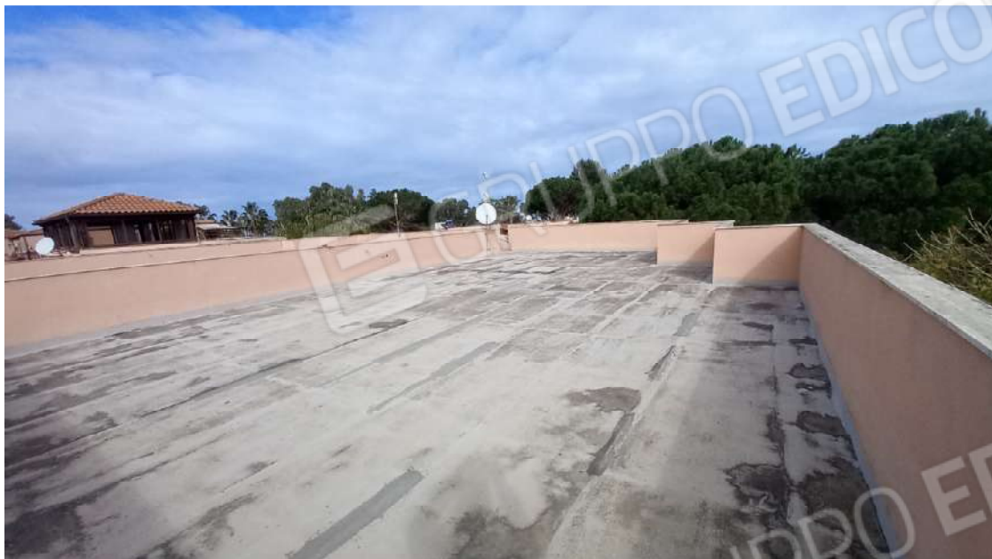
PARTICOLARE DEL LASTRICO SOLARE
