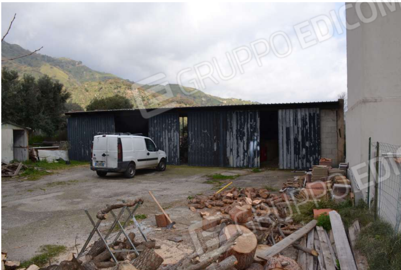
Foto 9 – Locale deposito di cui alla particella 2386.
