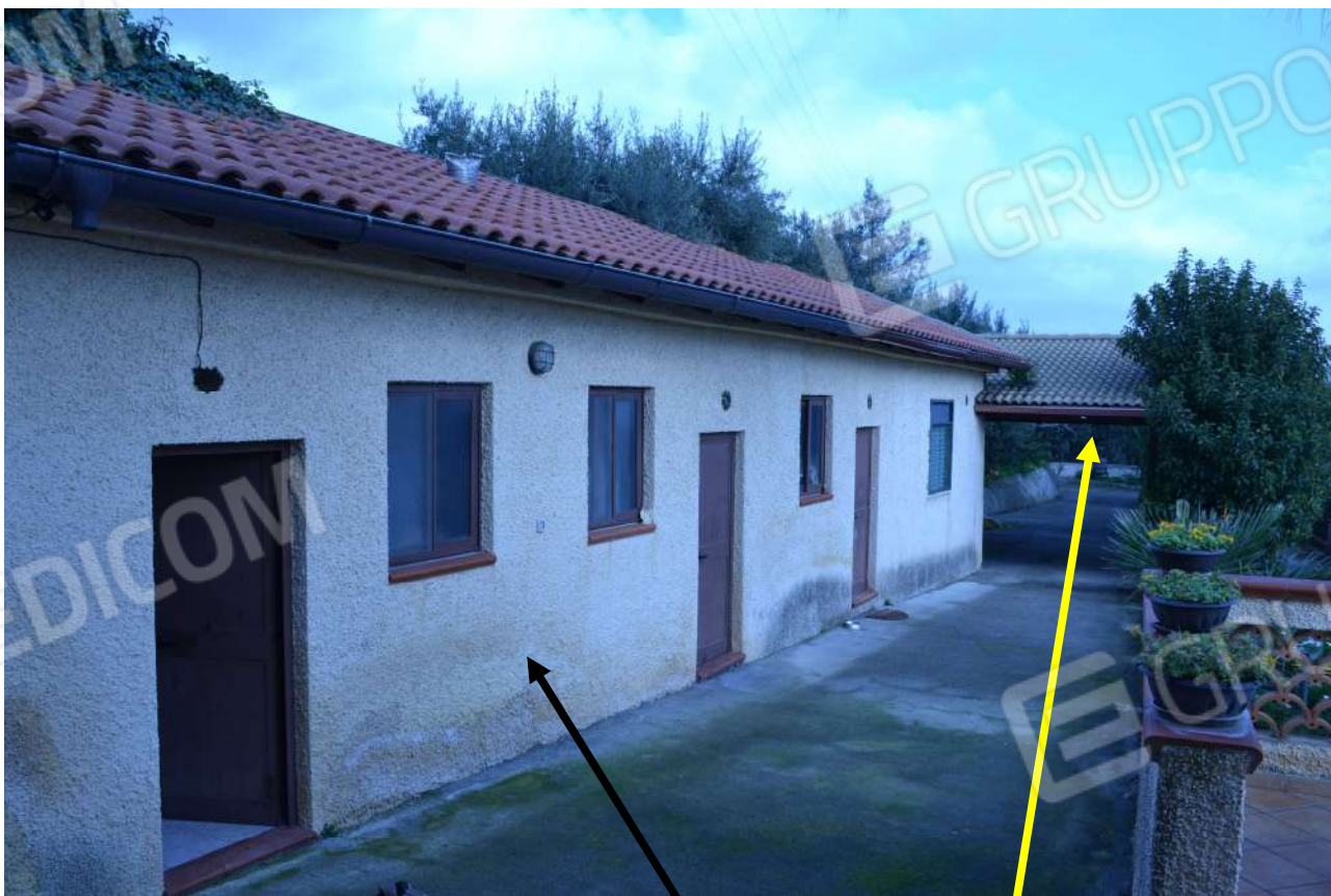
Foto 24 – Fabbricato adibito a deposito di cui alla particella 2267 sub. 4. Tettoia part. 2387
