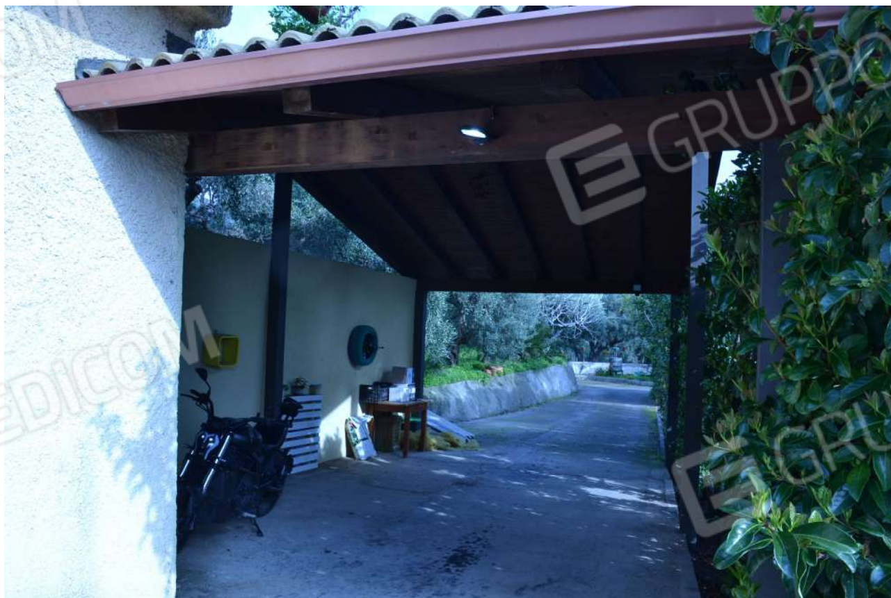
Foto 22 – Tettoia aperta prospetto sud di cui alla particella 2387.
