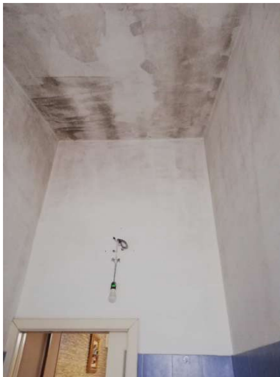
Particolare umidità – bagno in camera
