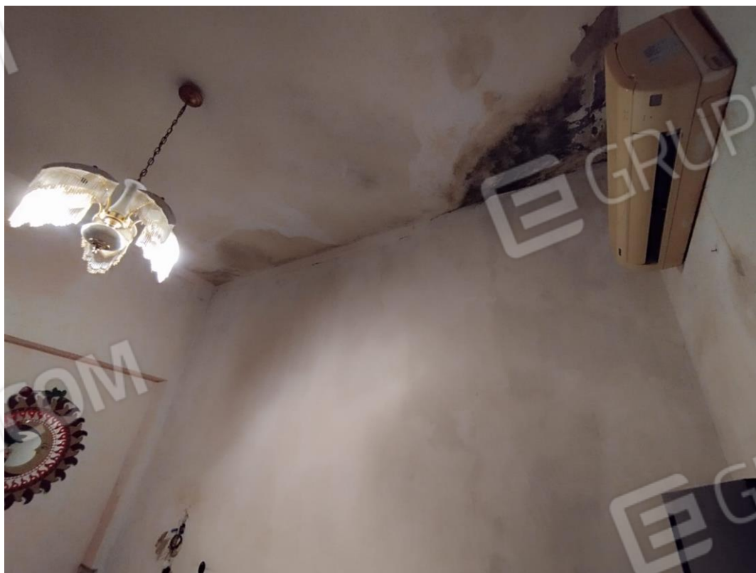
Foto n.15-16 : Evidenza dello stato di ammaloramento del soffitto ,infiltrazioni e muffe ;
