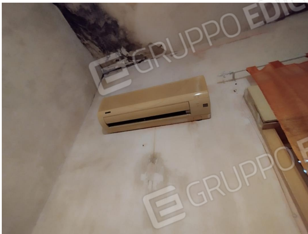
Foto n.15-16 : Evidenza dello stato di ammaloramento del soffitto ,infiltrazioni e muffe ;
