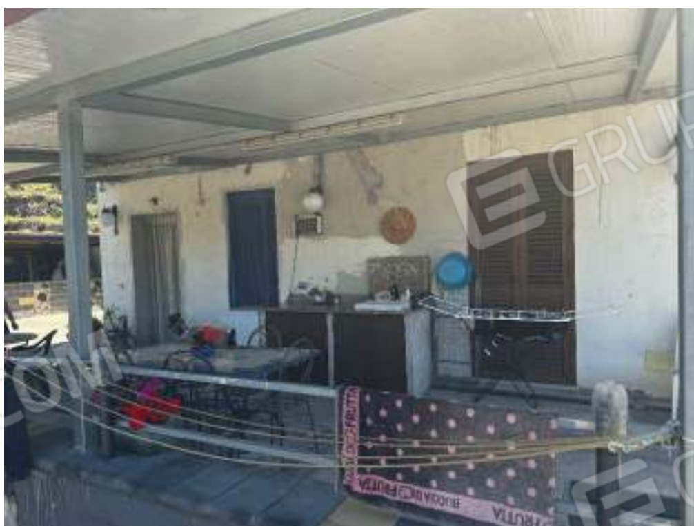
Figura 2 Vista ingresso piano P-1 in cui si nota la difformità delle aperture rispetto al progetto approvato
