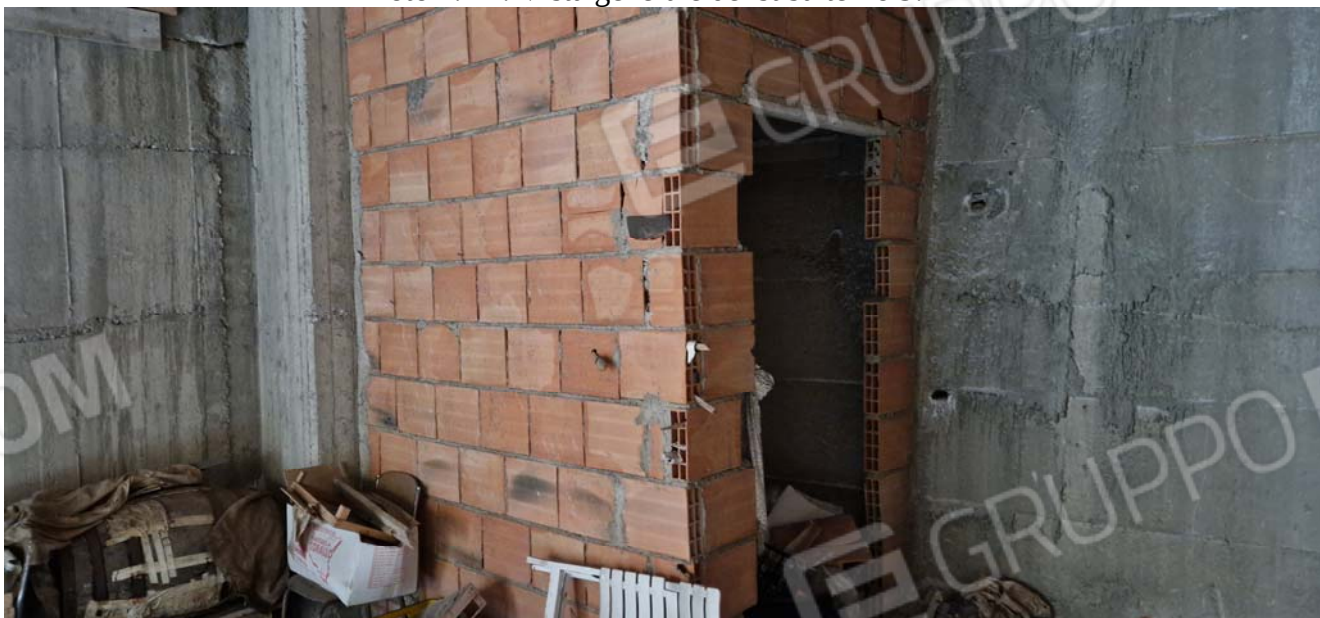
Foto n. 13: Vista generale del subalterno 9.
