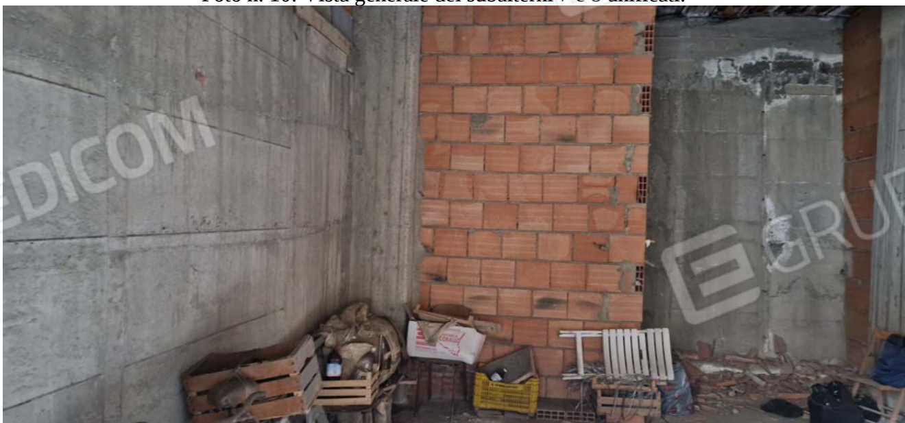
Foto n. 11: Vista generale del subalterno 9.
